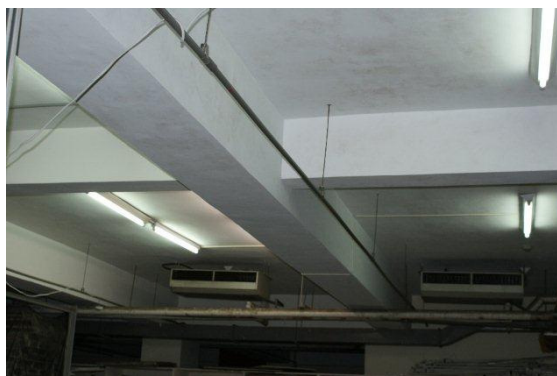
圖 4-22 倉庫內天花板下方既有取樣管
