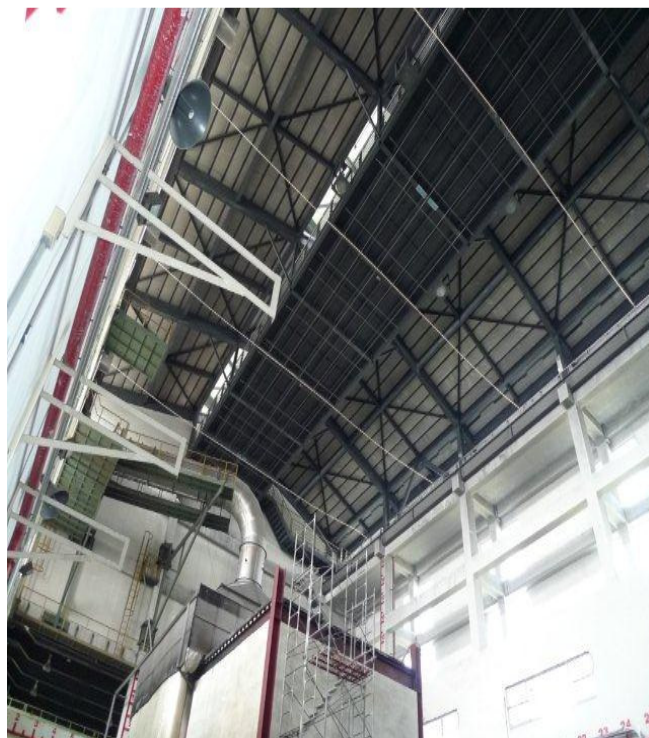
圖 4-4 水平配管現場情形
