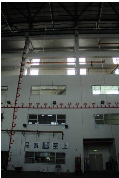
圖 4-3 垂直配管現場情形
