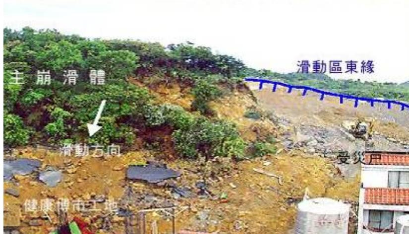
照片 2.1 滑動區東緣，滑落的土石衝壞擋土牆及路基，壓毀施工中的工地，並波及右側的民宅。
