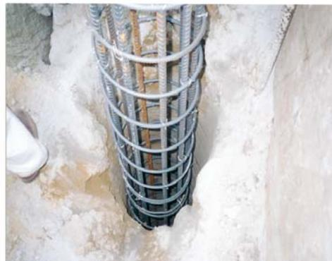
圖 8.3 場鑄混凝土排樁擋土壁工法
