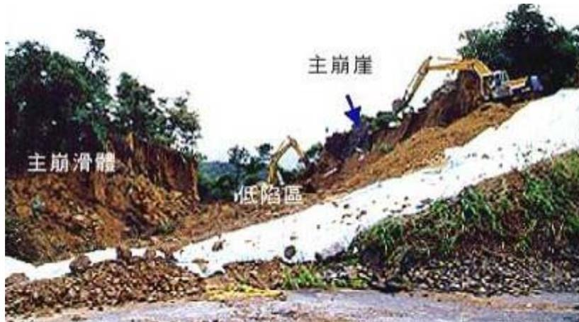
照片 2.5 介於主崩崖與主崩滑體之間，為地層滑動後所造成地形上的低陷區，低陷區的底斜面即為滑動面。
