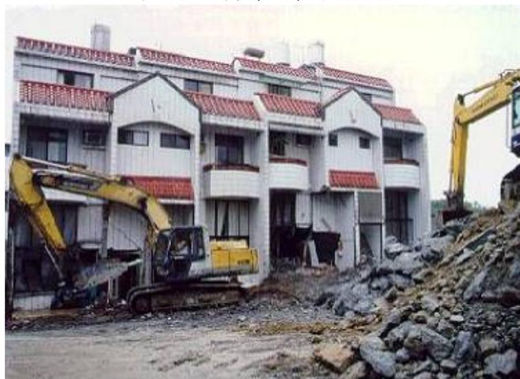
照片 2.3 美的世界社區靠近滑動區的四戶民宅(教孝街三巷 43、45、47、49 號)，遭受滑落土石衝擊後，房屋外部結構損壞情形。
