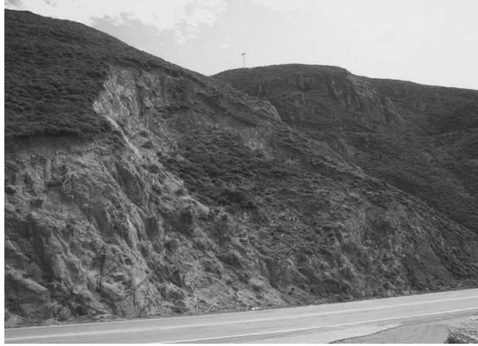
圖 4.18 高度風化花崗岩之圓弧型邊坡滑動破壞(Wyllie & Mah, 2004)
