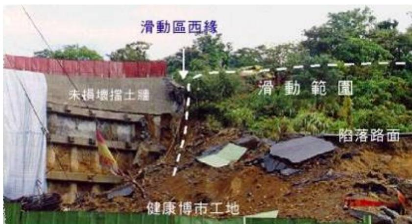
照片 2.2 滑動區西緣，左側為未損壞之開挖邊坡擋土結構，開挖高度達 15 公尺，圍籬後方為殘留之道路，右側道路已塌陷，健康博市工地為滑落之土石掩埋，幸未發生人員傷亡事件。
