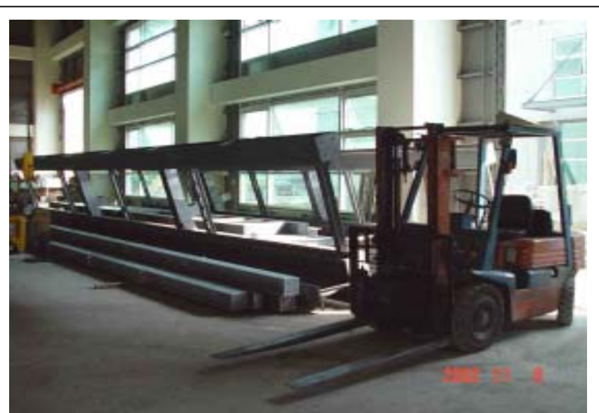
圖七十四 (骨架基座進場施工)
