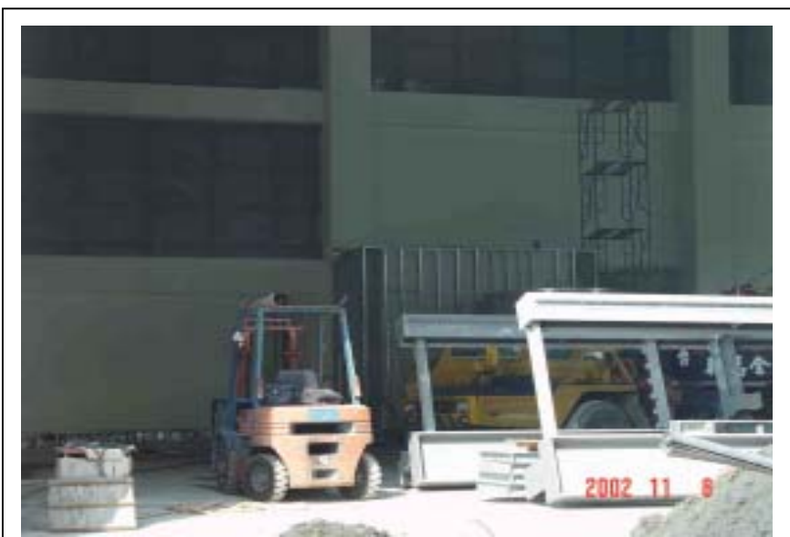
圖七十三 (骨架基座進場施工)
