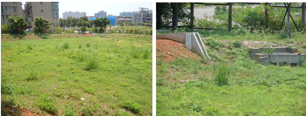
圖 2-17 新北市林口區南勢國小社區型調節池
