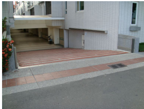
a. 地下空間擋水板設置案例
