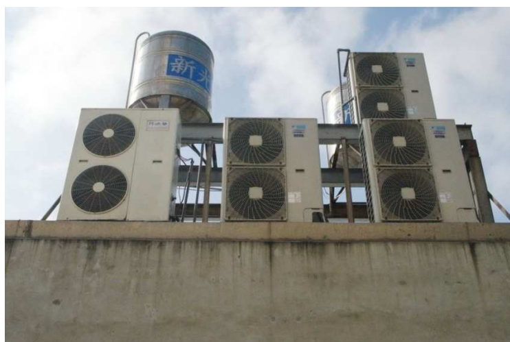
圖 5-7 室外機維持一定的清潔度也可增加冷氣機運轉效率
