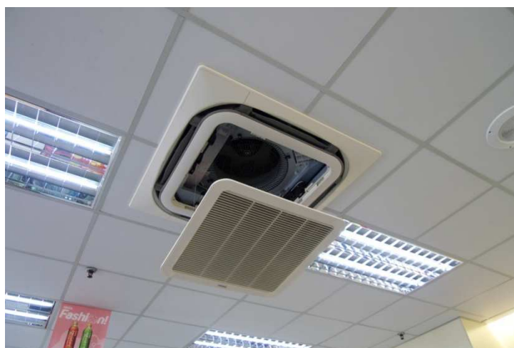
圖 5-6 定期清洗冷氣濾網可增加冷氣機運轉效率
