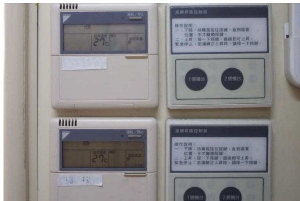
圖 5-5 冷氣機的溫度設定在 26~28°C 間
