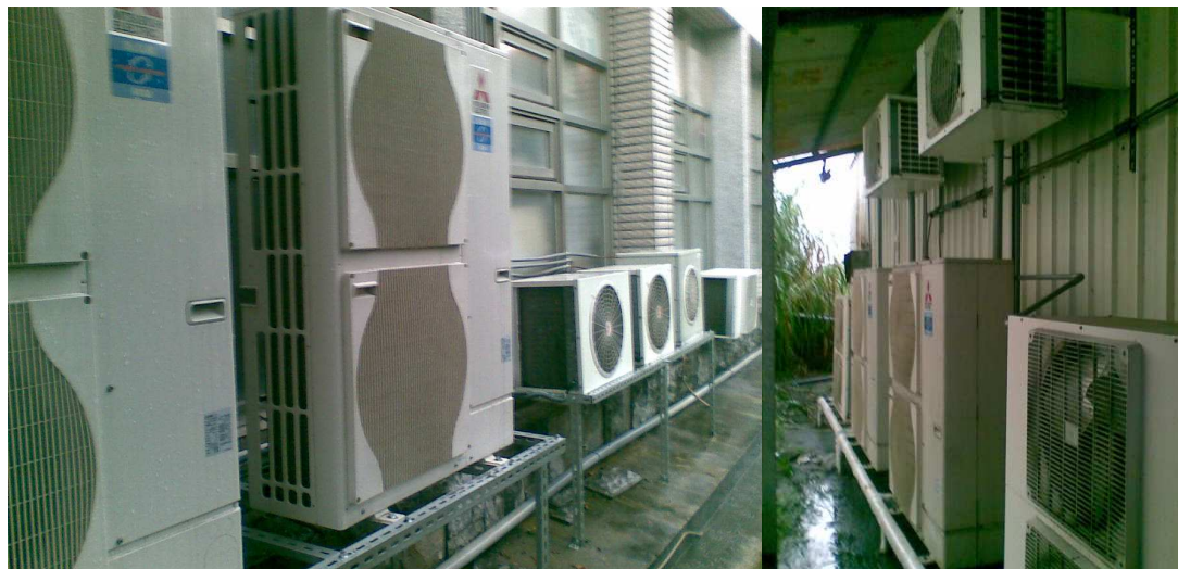
圖 3-31 OK-台南大內門市之現況照片
