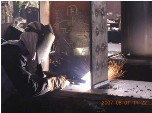
(e) 耐火鋼托梁翼板內緣碳棒吹蝕
