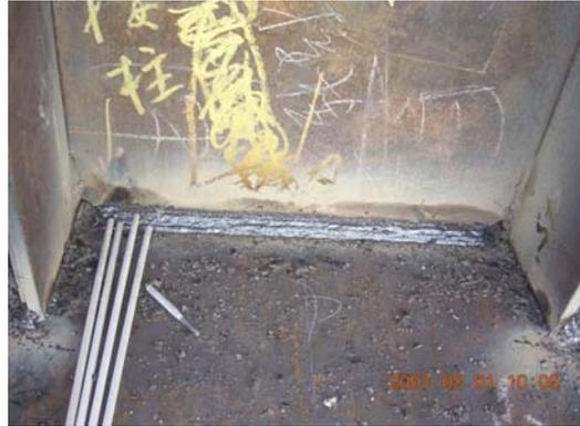
(c) 耐火鋼托梁腹板全滲透銲完成
