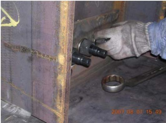
(c) 鋼梁定位及高拉力螺栓鎖固(人工)
