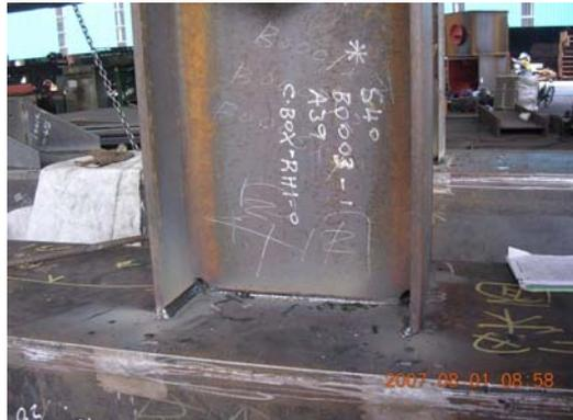
(c) 托梁翼板內緣全滲透鐸完成
