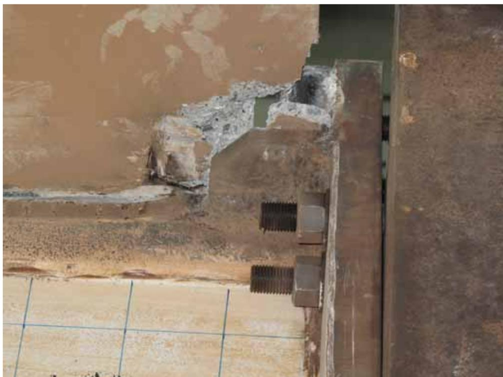
圖 4-22 梁 BM-EGLS 端點混凝土開裂
