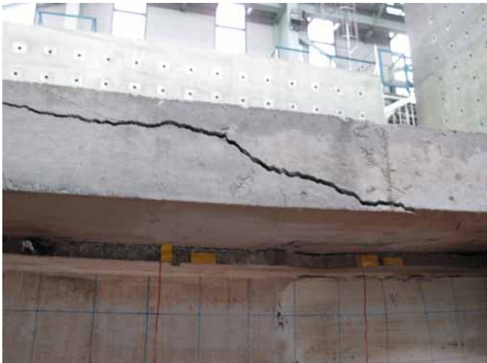
圖 4-21 梁 BM-EGLS 樓板開裂
