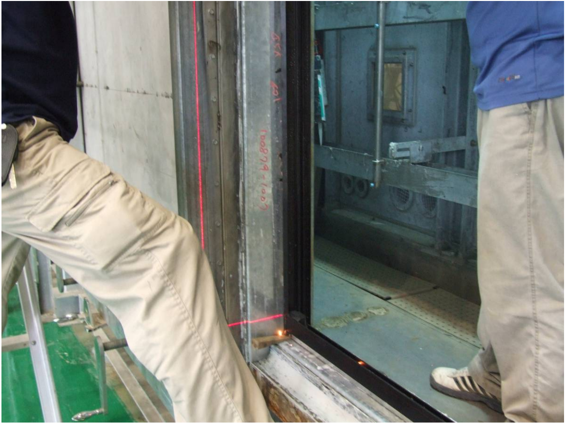
圖2-29 以雷射水準儀定位確保施工品質 資料來源：本研究整理
