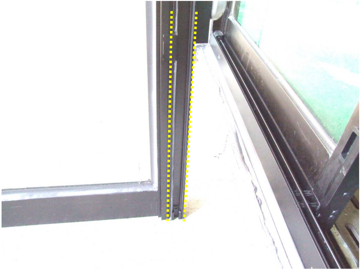
圖4-18 黃色點線為內扇窗戶兩條從上到下之氣密條將中間直料內的等壓空間包覆住
