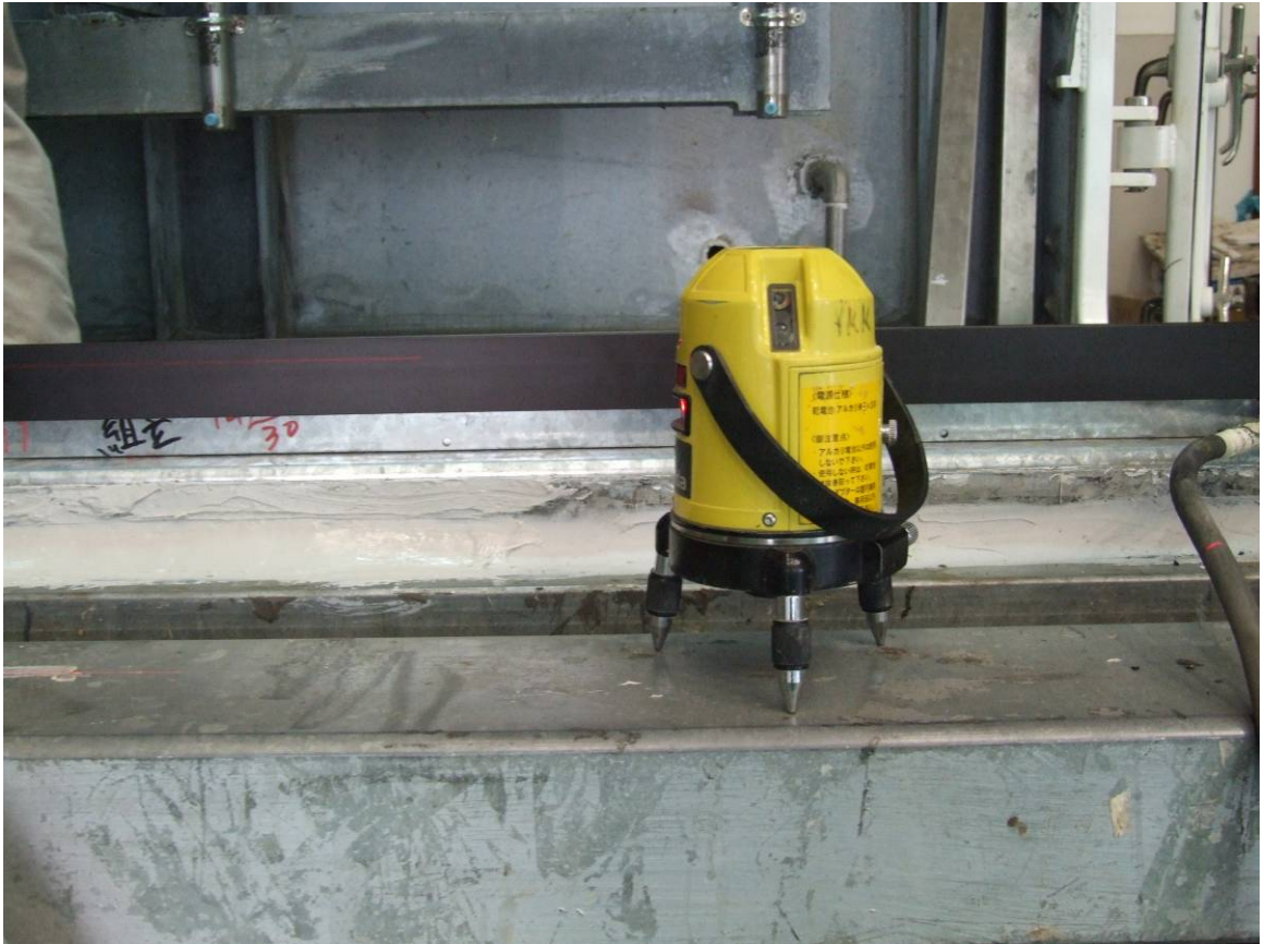
圖2-28 以雷射水準儀定位確保施工品質 資料來源：本研究整理
