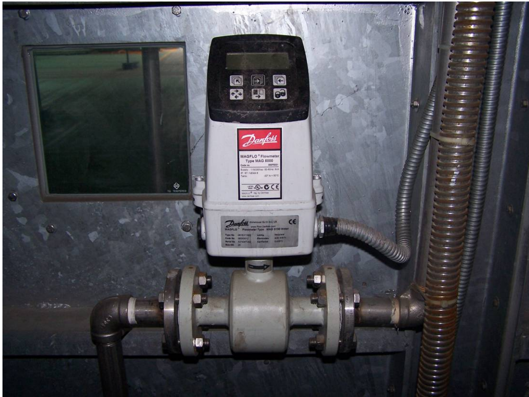
圖3-9 量測水流量之水流量計
