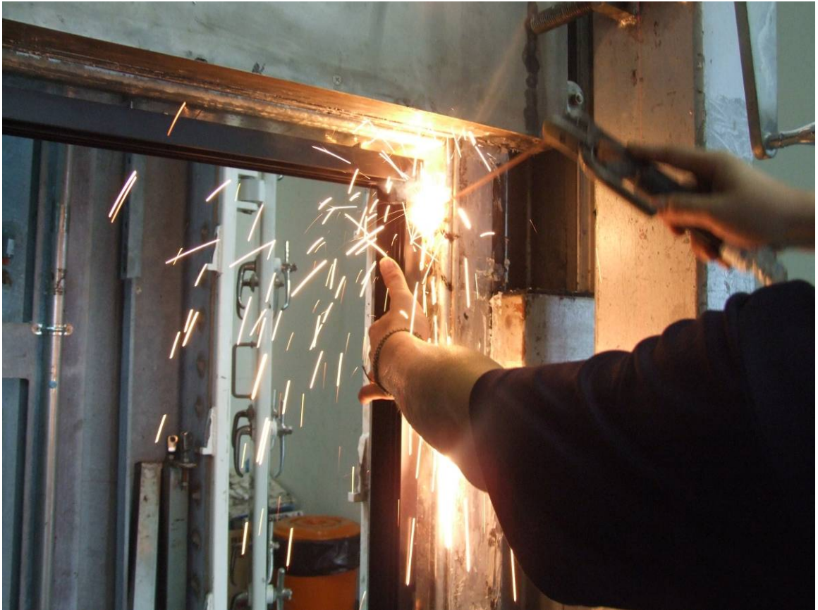
圖2-27 鋼骨建築的固定片以焊接處理
