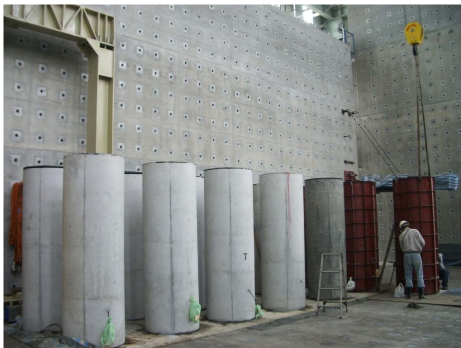
圖 3-30 RC 柱試體拆模後之照片(1)
