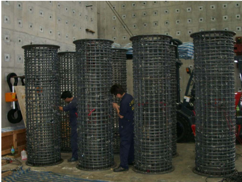
圖 3-23 預埋鋼筋應變計施工圖(1)
