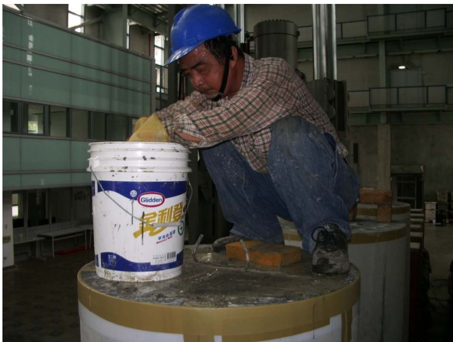
圖 3-32 試體頂部無收縮水泥漿施工圖(1)
