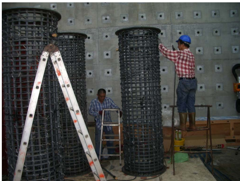
圖 3-22 圓形柱鋼筋組立完成圖 (資料來源：本研究)
