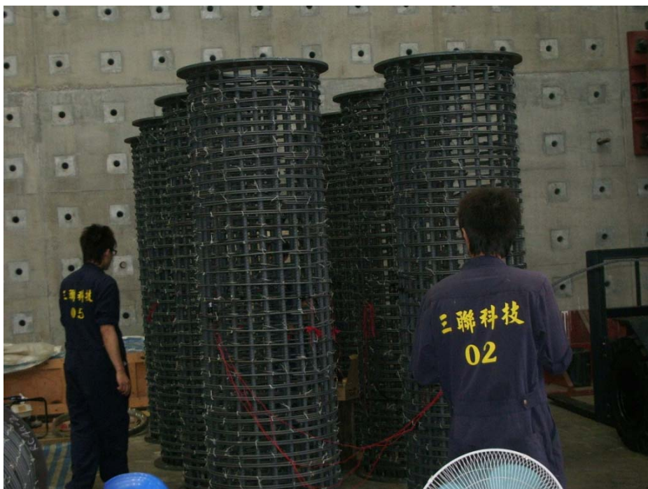
圖 3-24 預埋鋼筋應變計施工圖(2)
