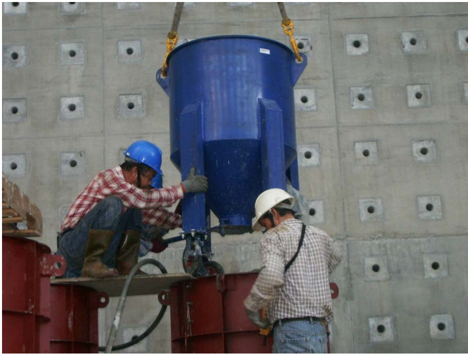
圖 3-27 試體澆置混凝土圖(2)
