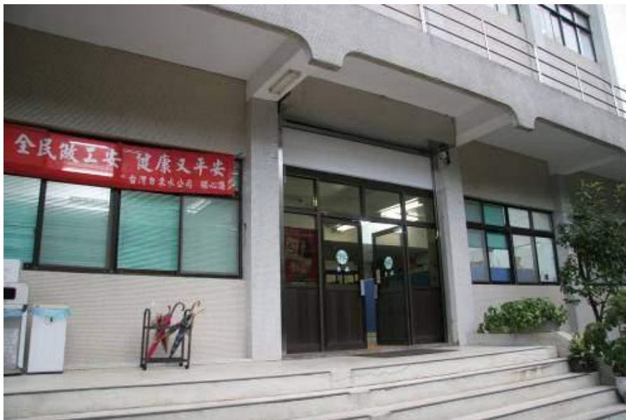
圖 3-1 自來水北區工程處大門外觀
