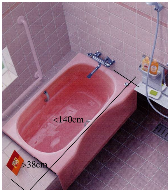
圖 4-82 轉位台示意圖 (資料來源 A-3)
