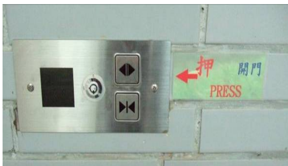
圖 4-93 電動門鎖示意圖
