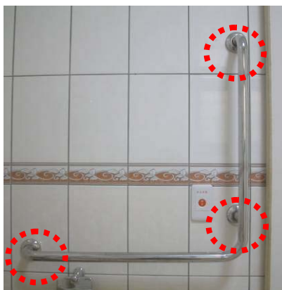
圖 4-26 扶手固定細部圖(單位:cm)
