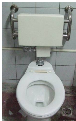
圖 4-35 靠背墊實品示意圖 (資料來源 本研究室整理)
