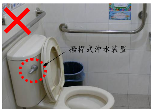
圖 4-30 撥桿式沖水控制器
