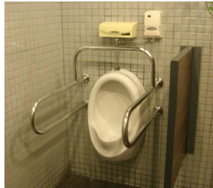
圖 4-50 小便器扶手示意圖 (資料來源 本研究室整理)
