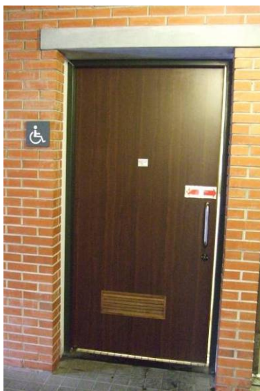
圖 4-92 手動式開啟入口門示意圖(木門)
