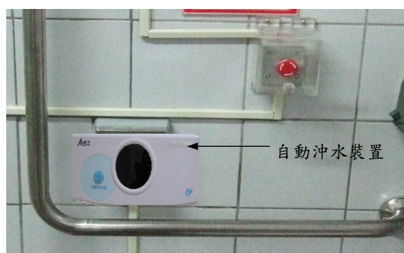
圖 4-29 沖水控制實品示意圖
