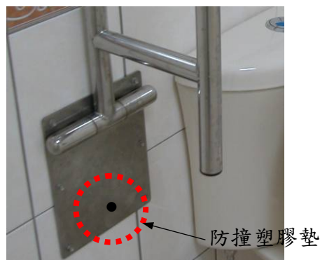
圖 4-25 扶手防撞細部圖-2 (資料來源 本研究室整理)
