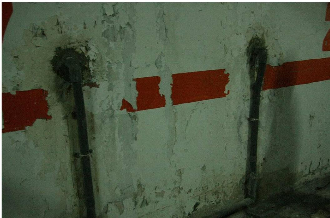
圖 3-7 摘星樓地下室鑽設大量地下排水管，顯示社區地下水位極高
