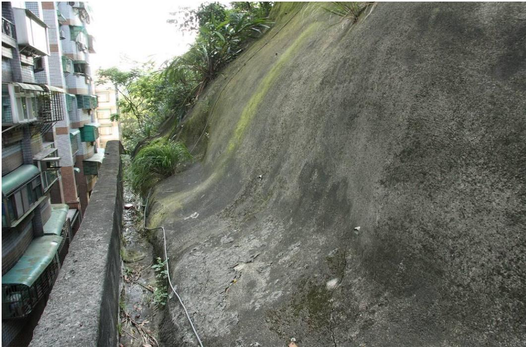
圖 2.7 擋土牆上方噴凝土護坡現況
