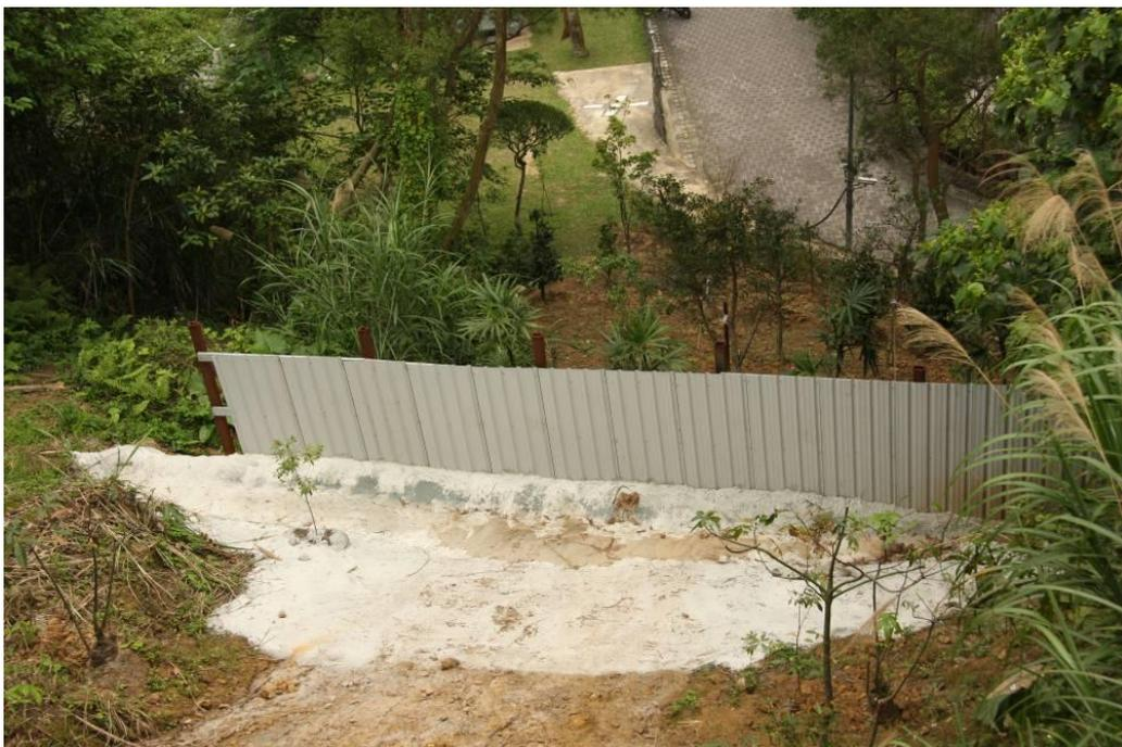
圖 1-6 邊坡臨時方型鋼樁及施作橫向截水
