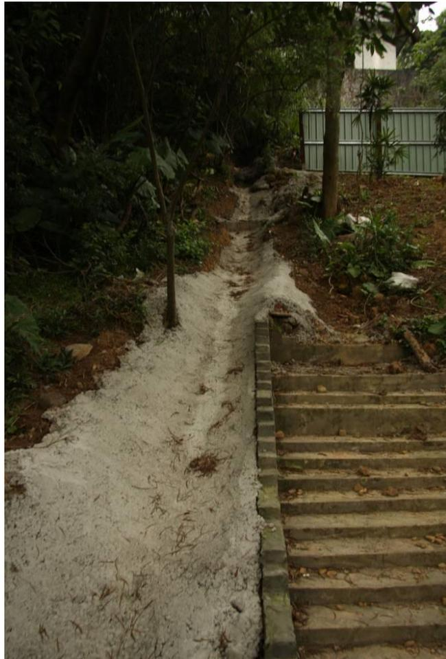
圖 1-5 邊坡臨時縱向排水溝 (拍漿溝)
