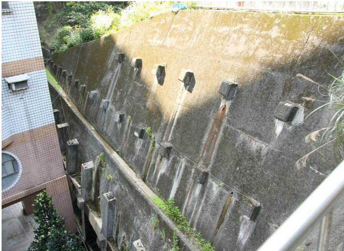
圖 2.4 大樓後方擋土牆長期地下水滲漏
