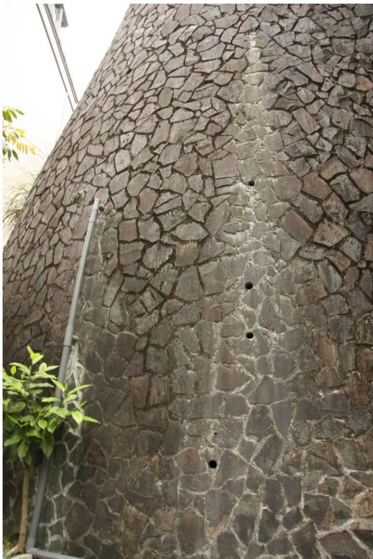
圖 1-9 排放口下方居民自行於擋土牆開孔及接管排水情況
