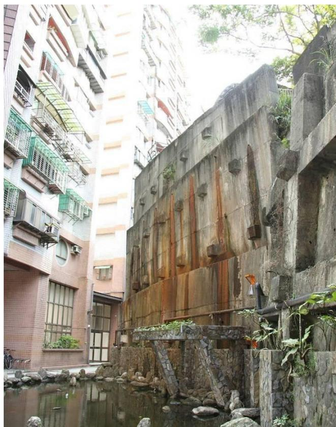
圖 2.6 大樓後方擋土牆地下水長期滲漏且擋土牆明顯外突傾斜
