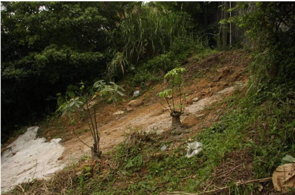
圖 1-4 邊坡下滑後出露之頁岩坡面
