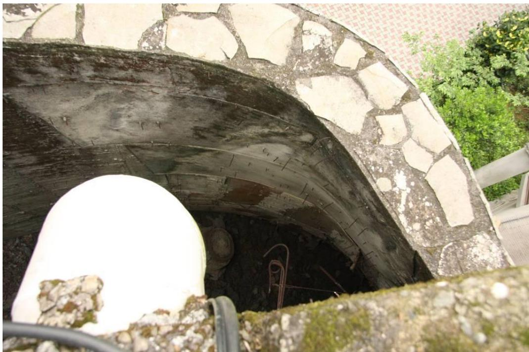
圖 1-7 擋土牆牆頂排水溝排放口逕流水直接排至擋土牆後方現況
