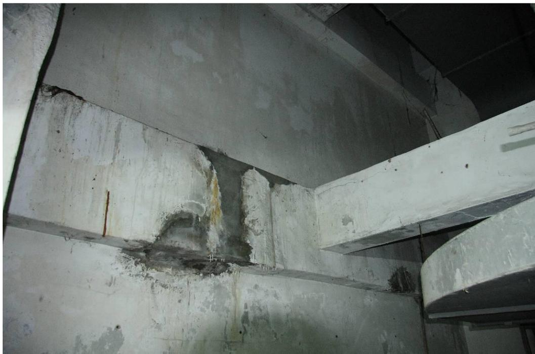
圖 2.9 地下室外牆兼擋土壁，牆面漏水、白華及梁受壓開裂情形(二)
