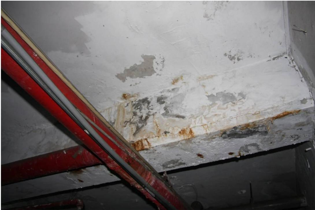
圖 3-5 魚池漏水造成梁版水泥漆脫落及白華產生情形
