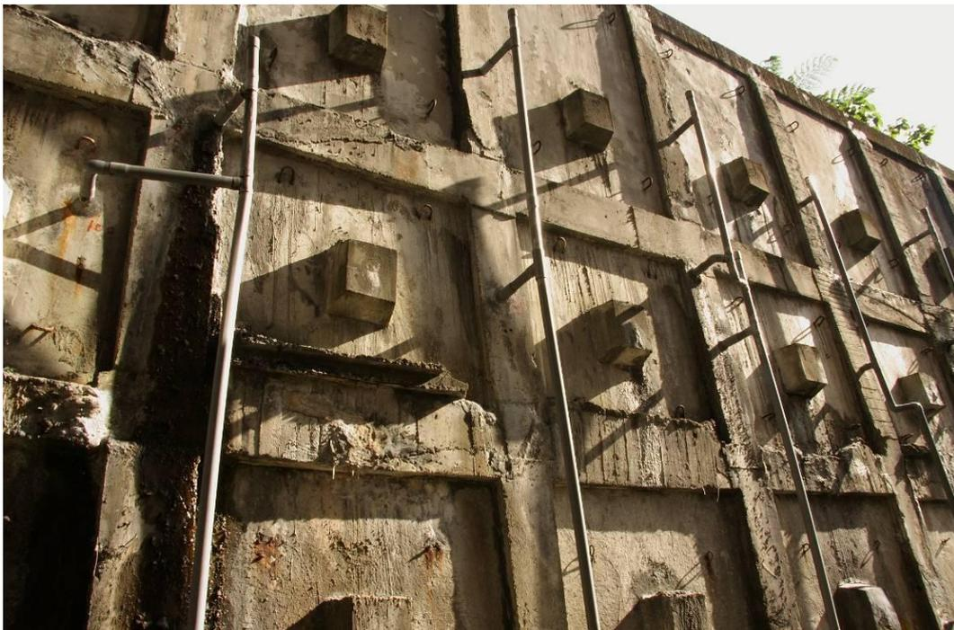
圖 3-6 迎旭樓及朝陽樓後方擋土牆地錨及排水孔位置不當且地下水位極高情形
