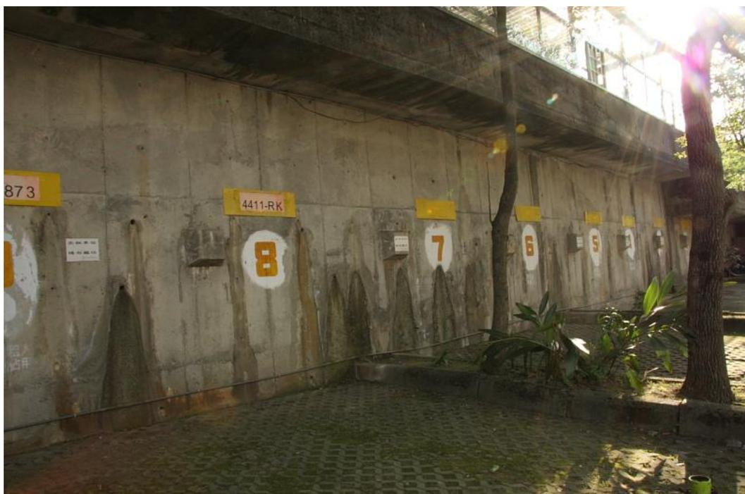
圖 3-8 社區擋土牆鑽設之地下排水管
