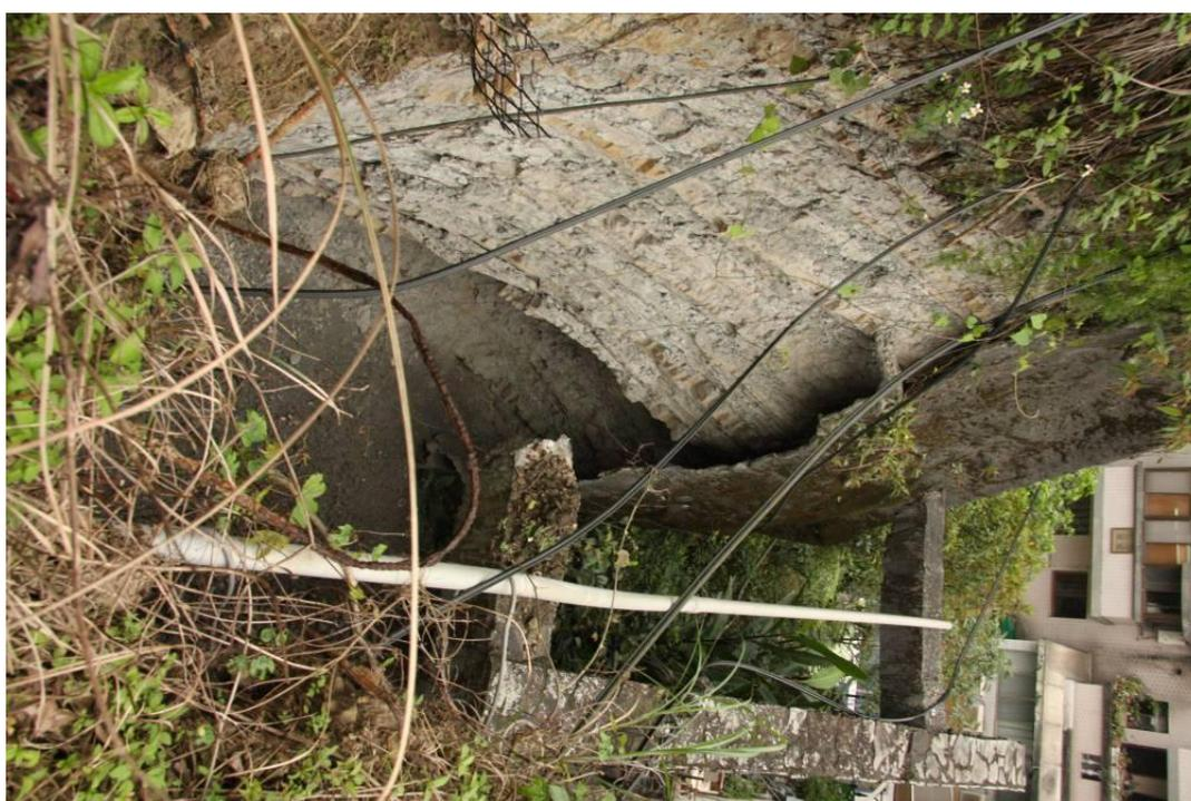
圖 1-8 邊坡、擋土牆後方土石遭沖刷、淘空現況
