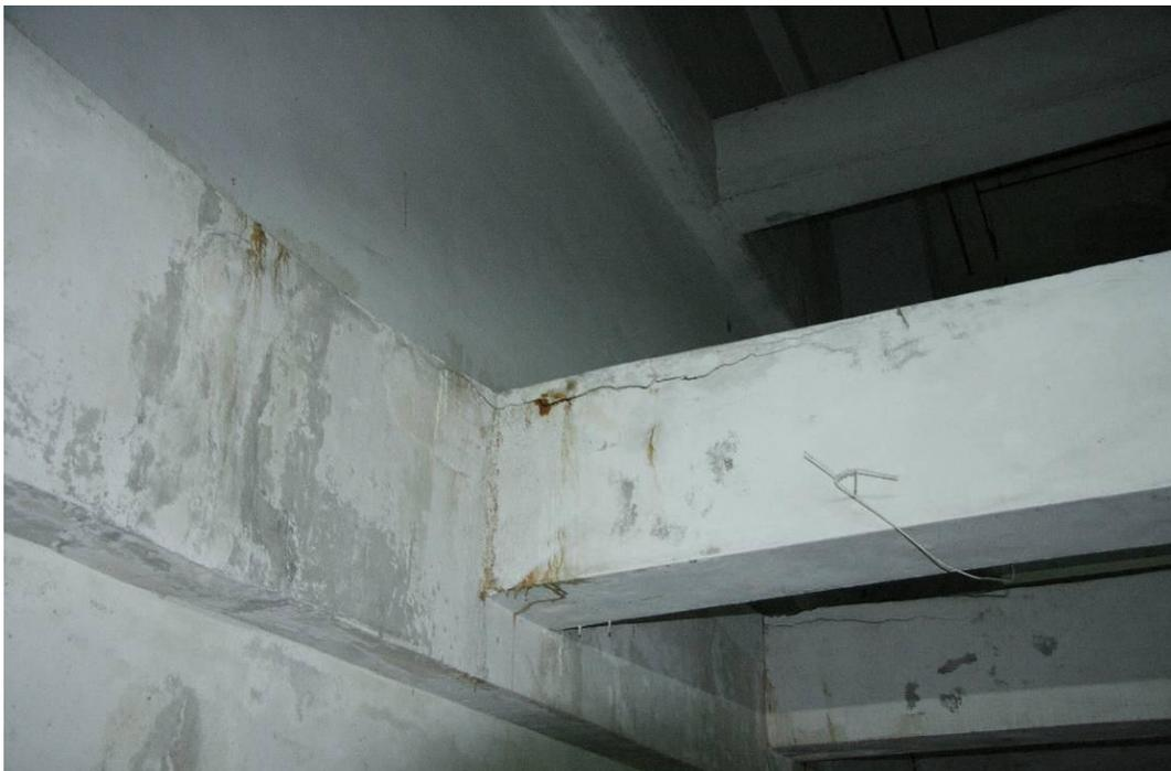
圖 2.8 地下室外牆兼擋土壁，牆面漏水、白華及梁受壓開裂情形(一)
