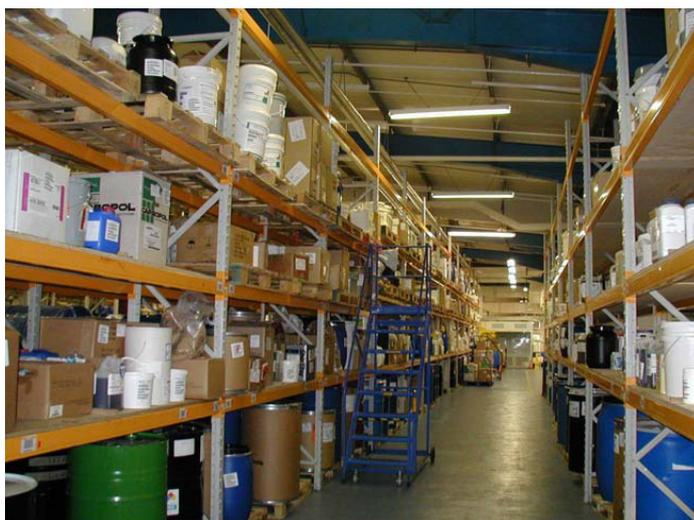
圖 1-3 一般傳統儲存倉庫貨架與建築結構各自獨立情形 [11]
