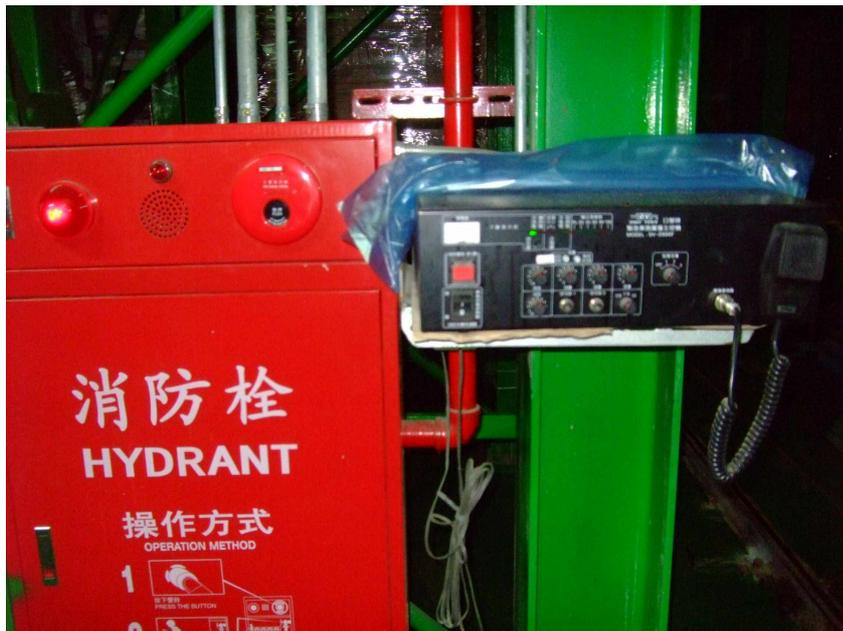
圖 4-6 倉庫內設有緊急通報設備及消防栓
