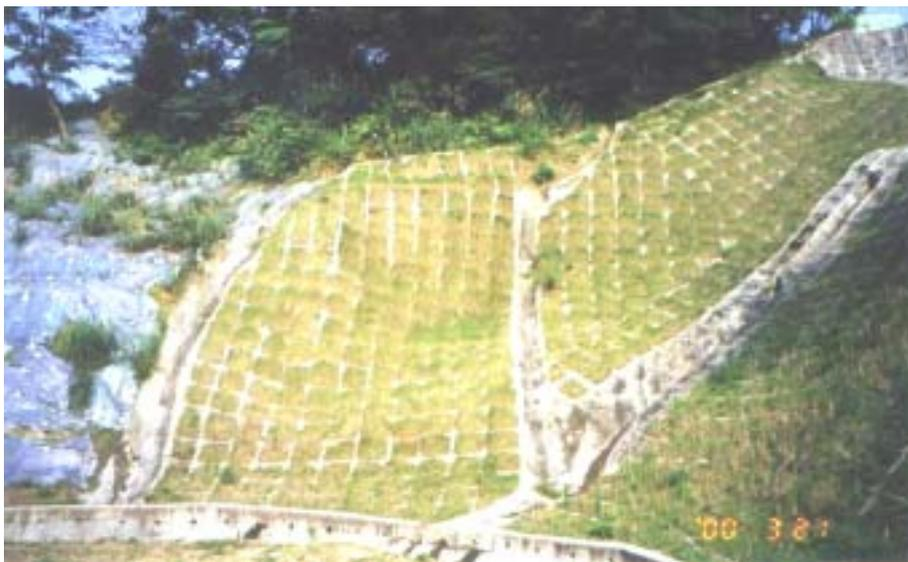
圖 6.24 案例 B-3 地滑區的頂部格框植生護坡整治並新設排水溝
