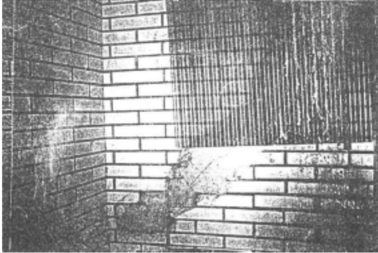
圖 6.22 案例 B-2 社區建物一樓房舍外牆龜裂情形
