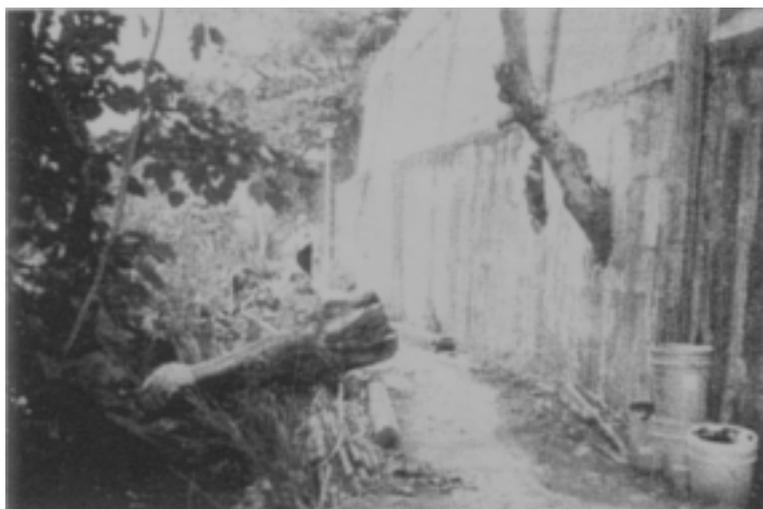
圖 4.6 擋土牆身未打設排水孔，以致聚集大量之水壓力
