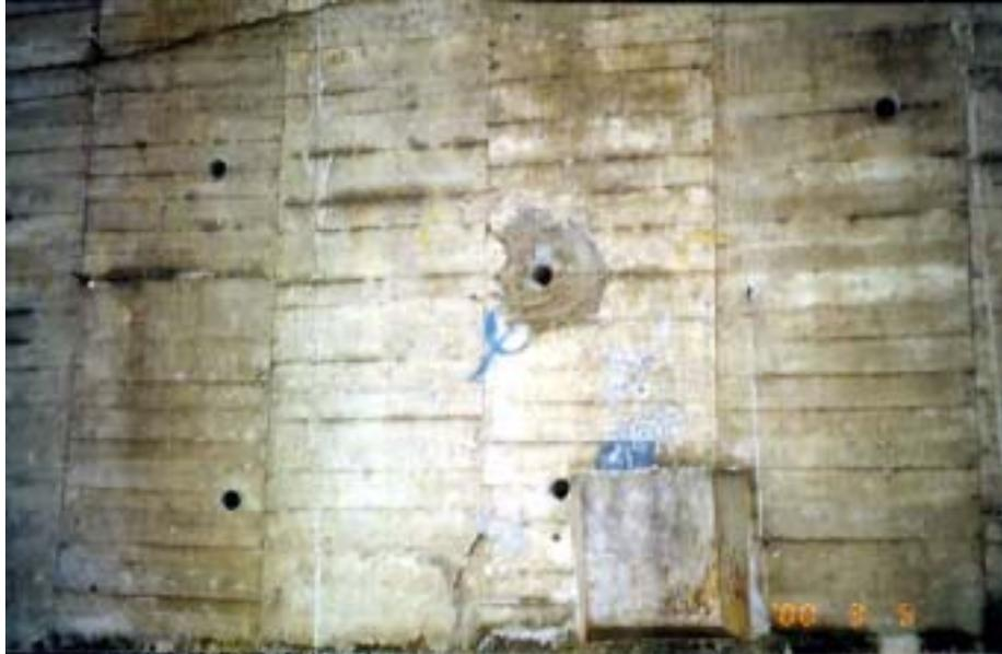
圖 6.3 案例 A-1 社區補充打設洩水孔
