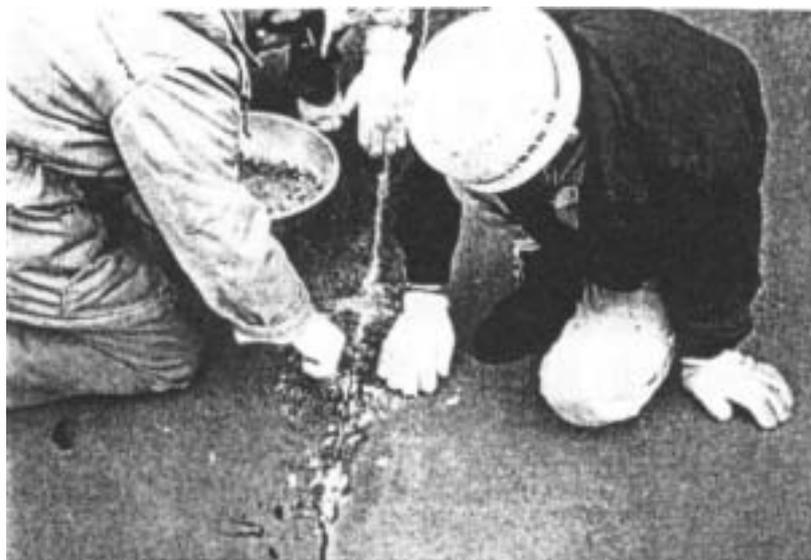
圖 5.6 以環氧樹脂填補裂縫示意圖 [ 6 ]
