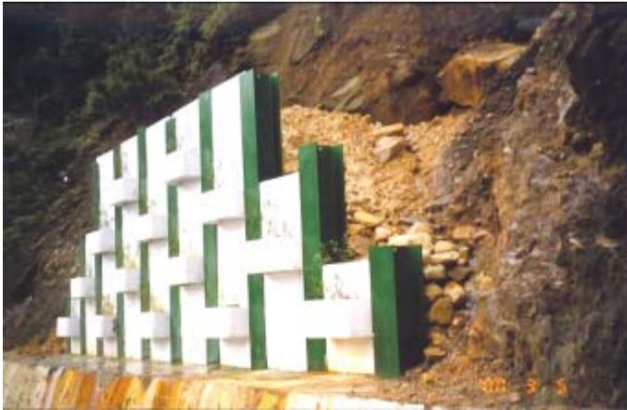
圖 6.13 案例 A-2 社區聯外道路邊坡攔石牆工程
