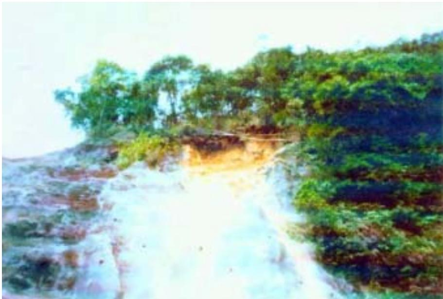
圖 6.10 案例 A-2 位置 S-2，現有噴漿面坡頂覆蓋層局部坍方，如遇豪雨極易坍方，影響社區聯外道路。
