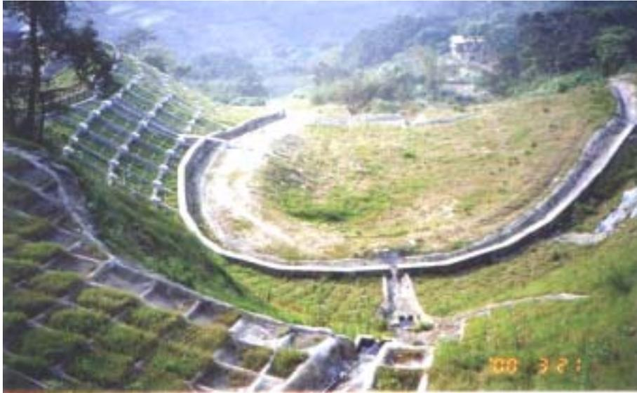
圖 6.27 案例 B-3 地滑區整治完成後之情形
