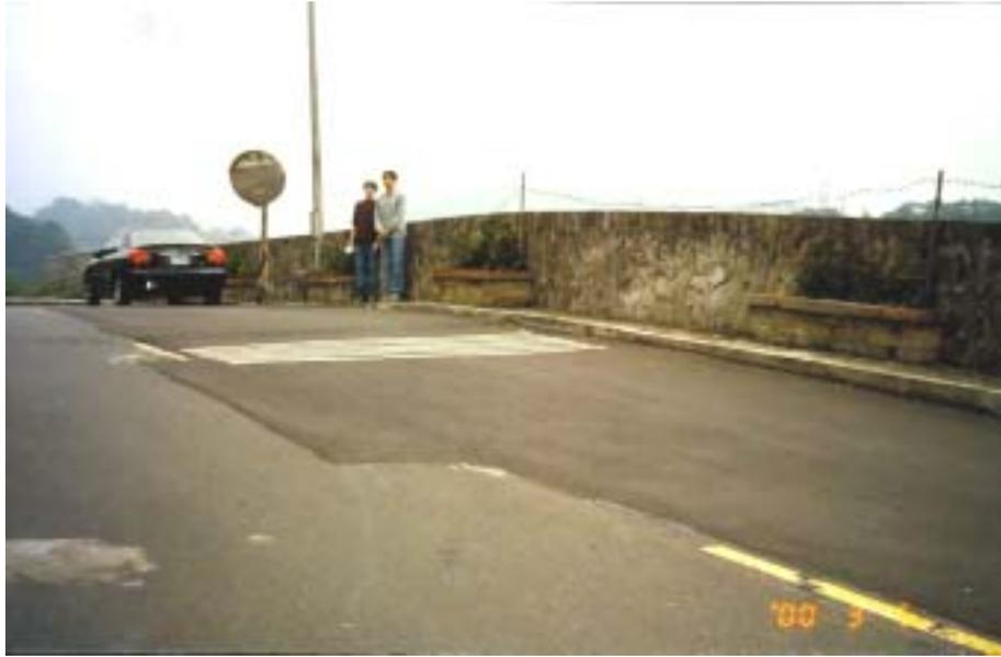
圖 6.5 案例 A-1 社區道路填土區發生空洞下陷區域改善整治後情形
