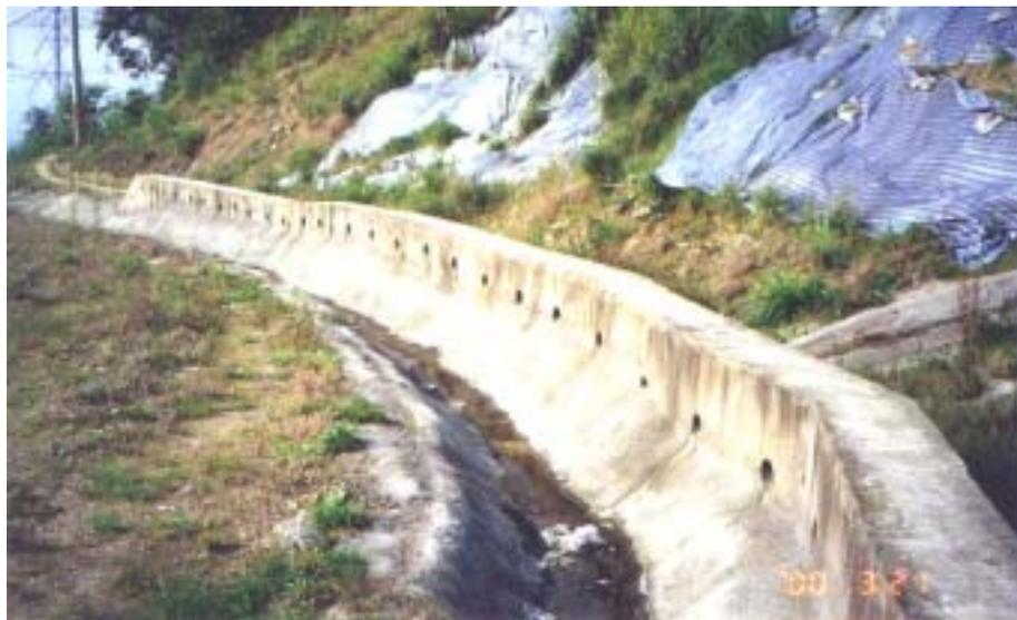
圖 6.26 案例 B-3 地滑區整修及新設排水溝，使其排水能延伸至下游的大排水溝。
