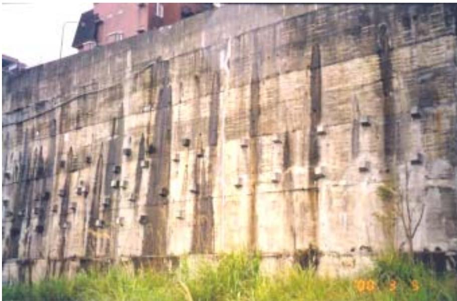
圖 6.2 案例 A-1 社區補強後擋土牆牆面
