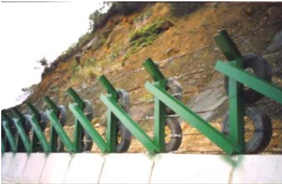
圖 6.12 案例 A-2 社區聯外道路邊坡落石欄工程
