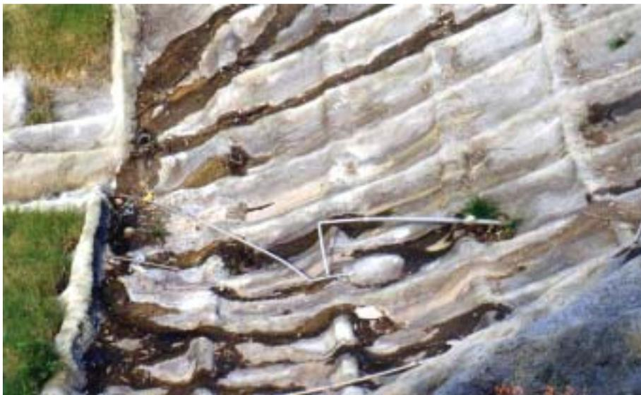
圖 6.28 案例 B-3 地滑區中段採用 PVC 管地下排水工程
