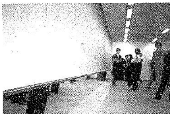
圖片 5-2 可穿越式防火布幕降下時的情況 (資料來源：日本火災學會雜誌-品川 Inter City，)
