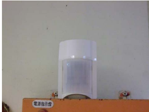
圖28 新裝設之紅外線感知器
