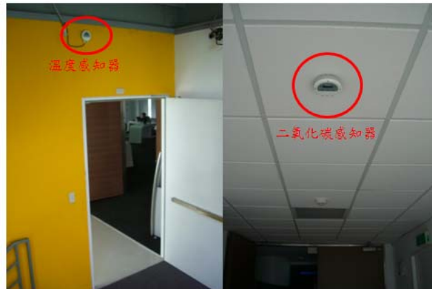
圖95 新設之溫度及二氧化碳感知器
