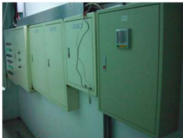
圖93 新設之數位電錶及控制盤
