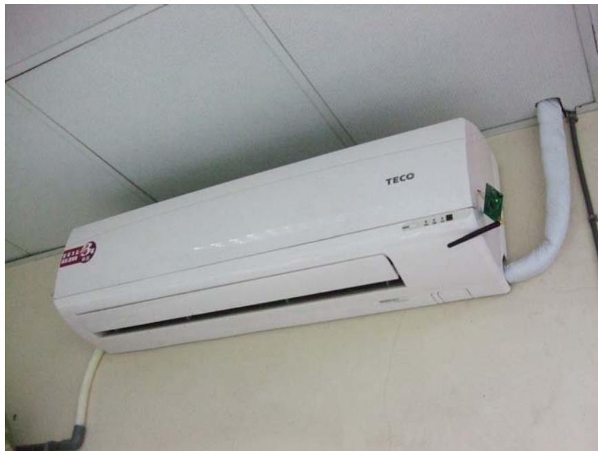
圖86 東元 MS63VC1 VRV 變頻式空調機實際照片
