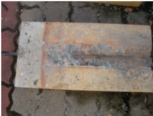
照片 3-16 黏結面處理(前)
