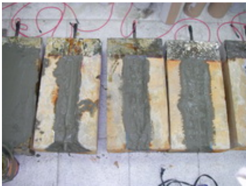
照片 3-18 塗上黏結層
