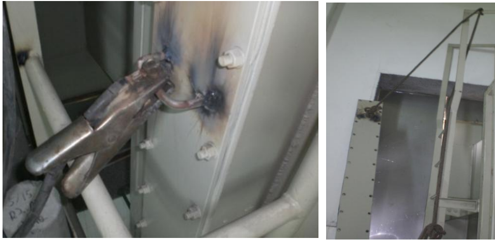
圖 5-4 風洞預留縫隙擋版拆除
