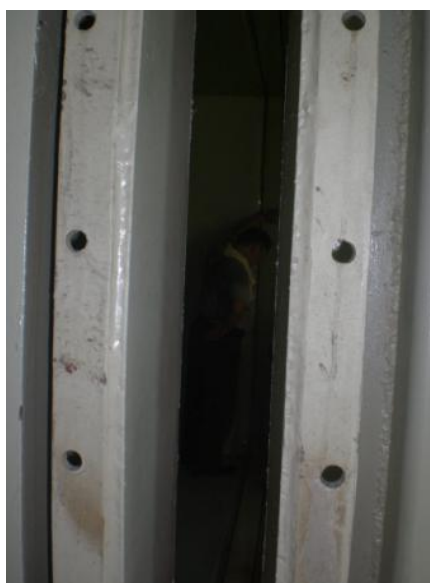
圖 5-5 擋版內預留縫隙約 12cm
