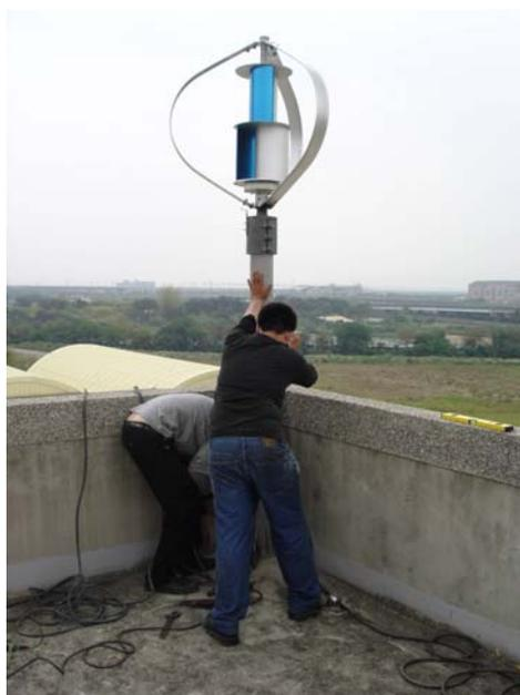
**圖5-1 風力發電機實場量測平台架設過程**
