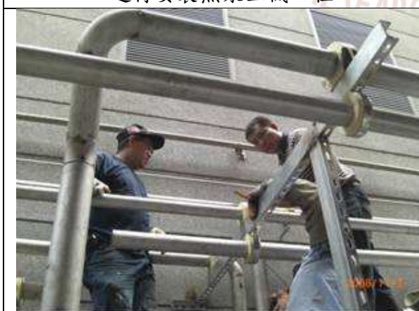
進行熱水管路配管工程
