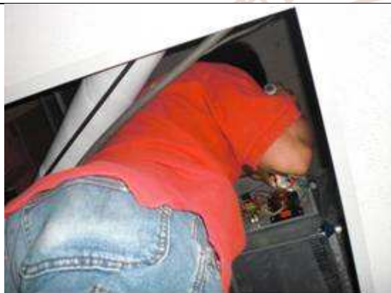
VAV BOX 檢修
