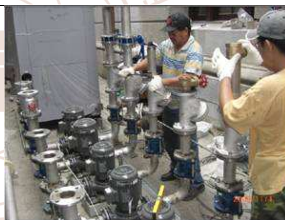
設置熱泵主機及泵浦等設備
