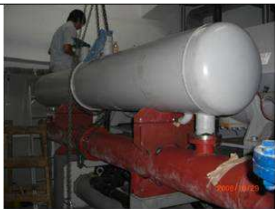
既有冰水主機加裝熱回收器
