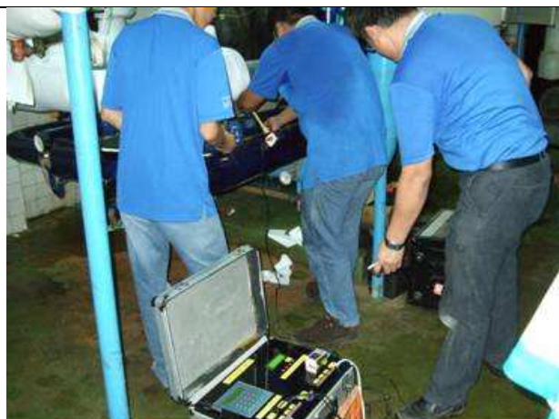
冰水管路流量數據擷取記錄
