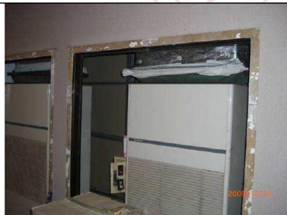
汰換原 277 會議室之老舊箱型冷氣機
