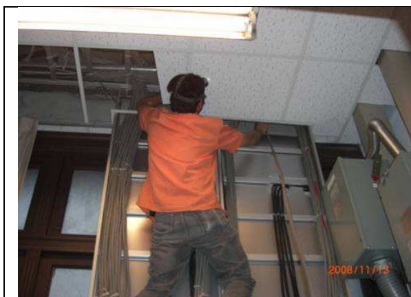
進行電梯出口處照明控制迴路調整工程
