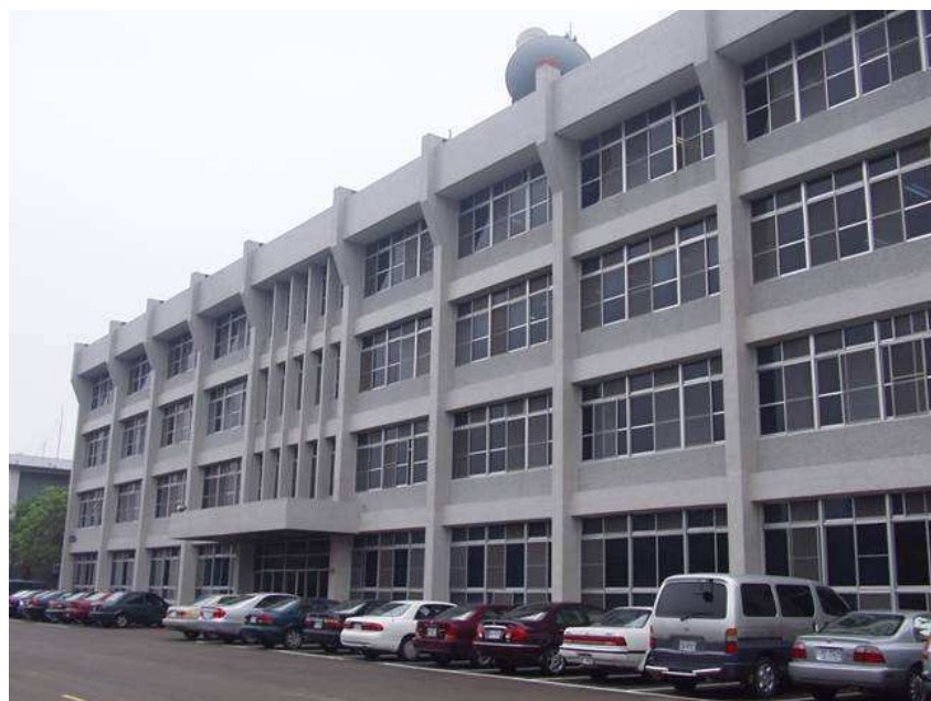
圖 2.38.1 經濟部漢翔航空工業有限公司安翔大樓之建築外觀圖
