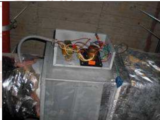
VAV BOX 檢修
