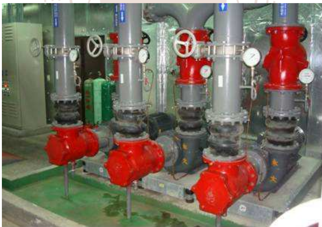
圖 2.17.3 總統府既有之冷卻水泵群
