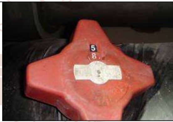
2F 冰水管之平衡閥開度調整至 5.8
