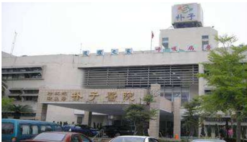
圖 2.28.1 行政院衛生署朴子醫院之建築外觀圖
