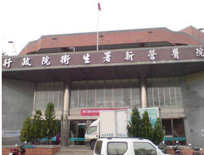
圖 2.24.1 行政院衛生署新營醫院之建築外觀圖
