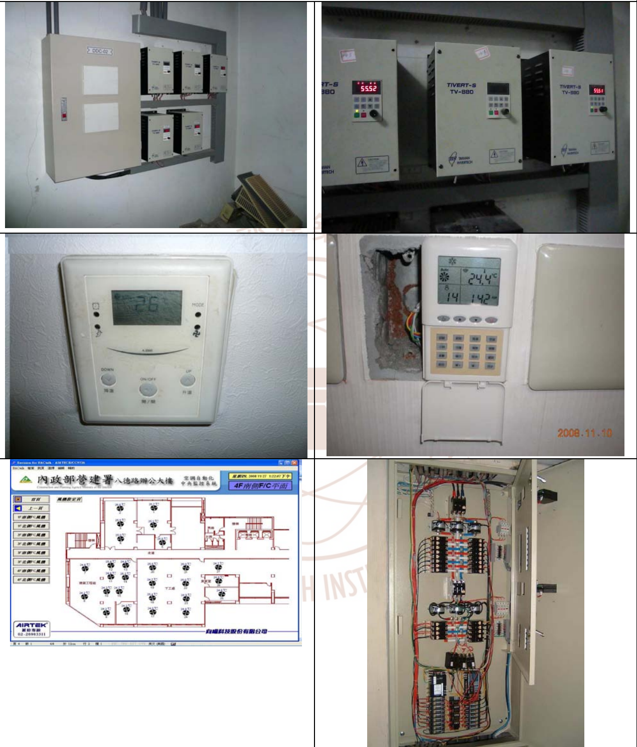
設置空調中央監控及能源管理系統
