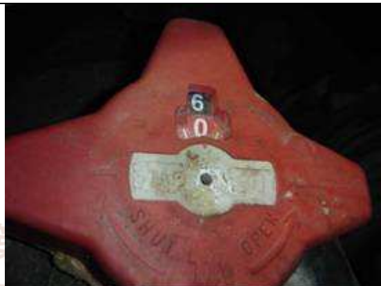
3F 冰水管之平衡閥開度調整至 6
