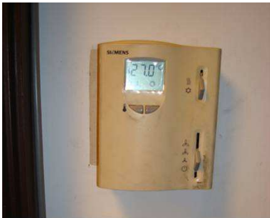
圖 2.17.4 總統府原有之類比式室內溫度控制器
