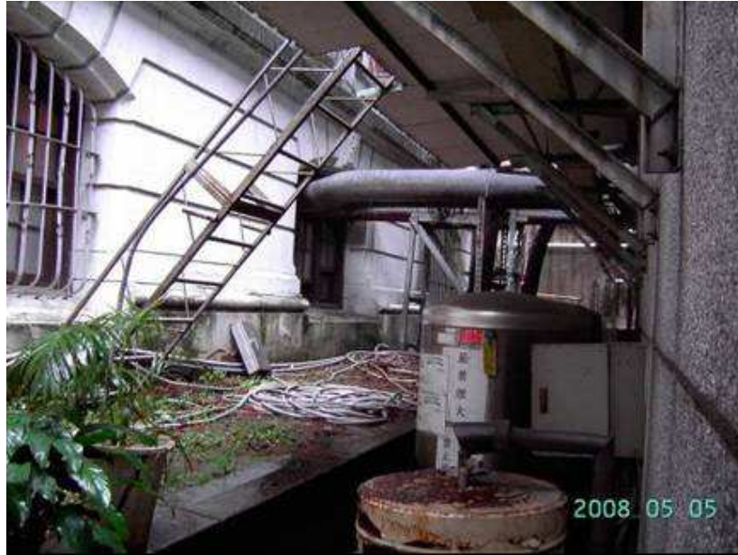
圖 2.17.10 總統府既有之電熱水器
