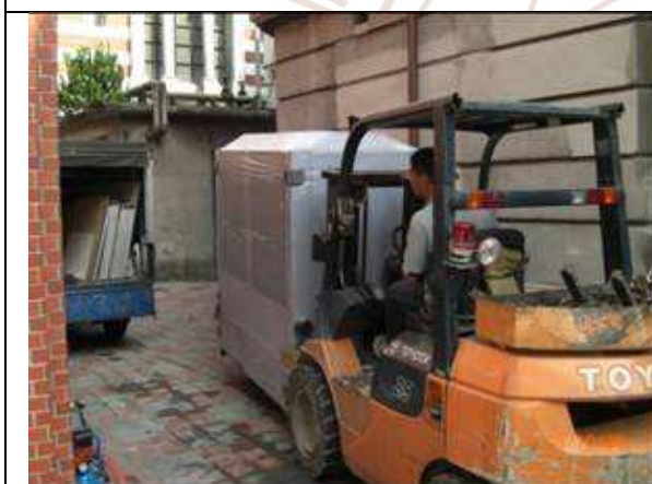
進行安裝熱泵主機工程
