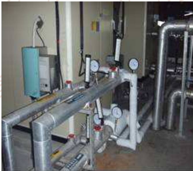
圖 2.34.4 行政院衛生署彰化醫院既有空調箱
