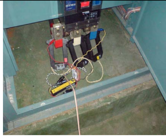
台電大寮訓練所於主機配電盤進行耗電量之記錄及計算
