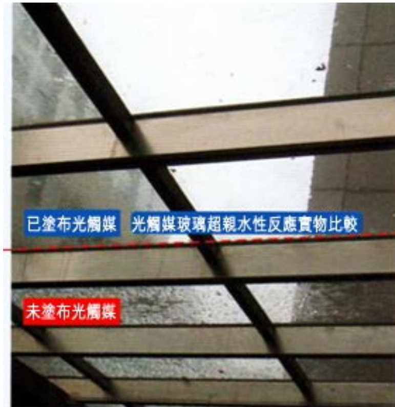
圖 2-10 光觸媒玻璃示意圖
