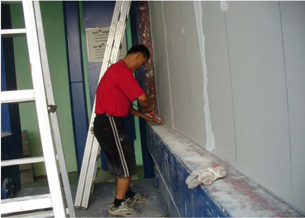
圖3-11 silicone填補施工情形
