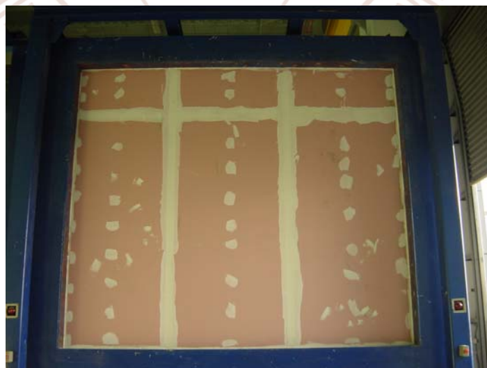
圖4-15 施工完成照片
