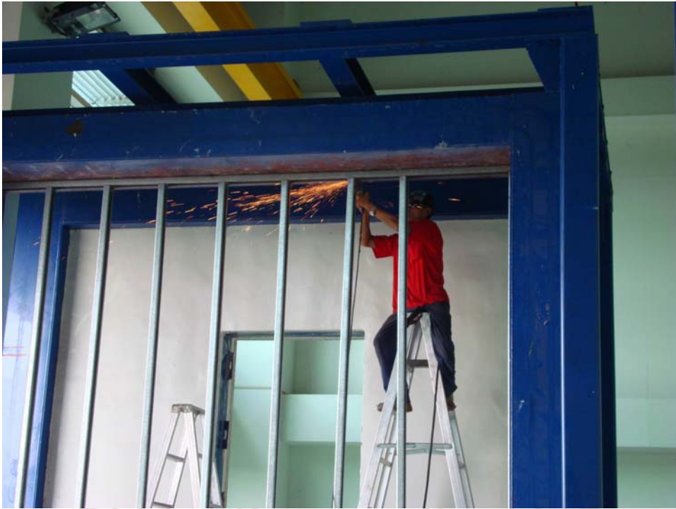
圖3-7 骨架垂直置入施工情形
