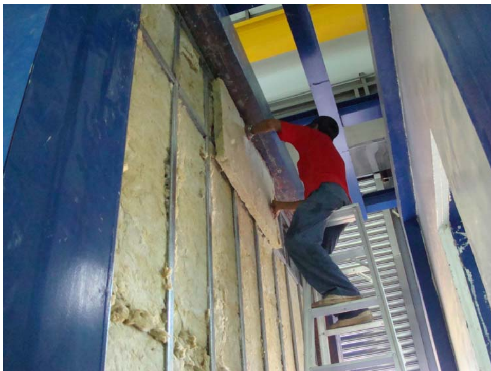
圖3-9 吸音材填充施工情形
