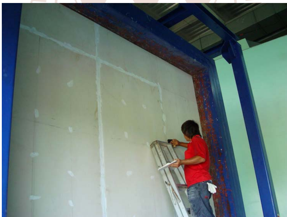
圖3-10 接縫膠泥施工情形
