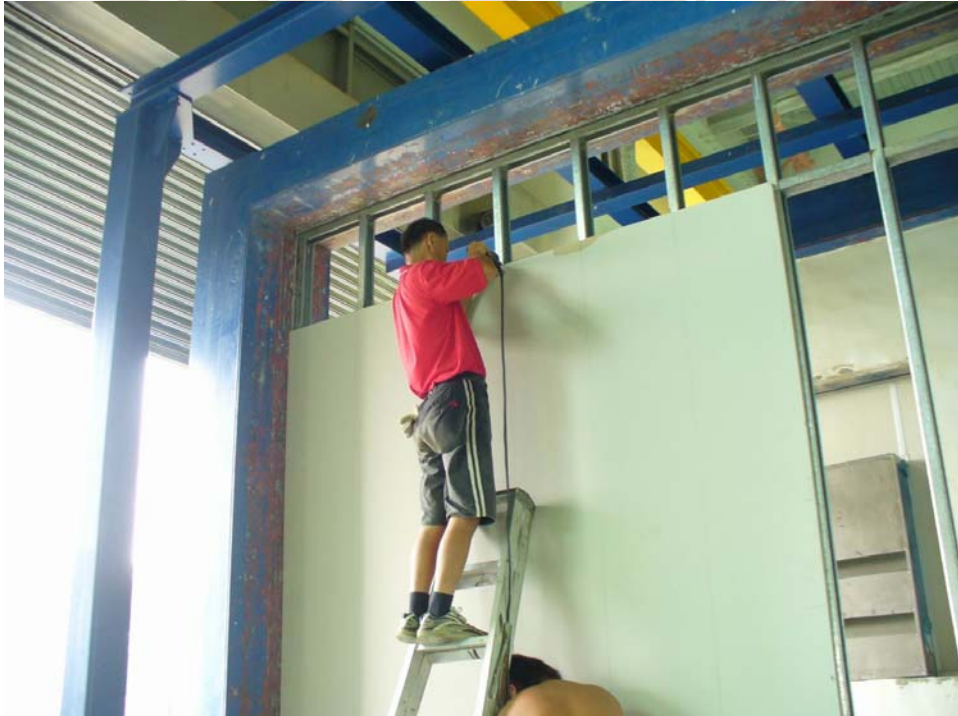
圖3-8 面材施工情形
