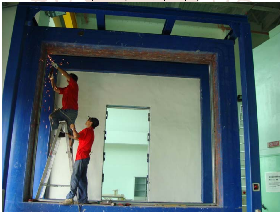
圖3-6 骨架放樣及焊接施工情形
