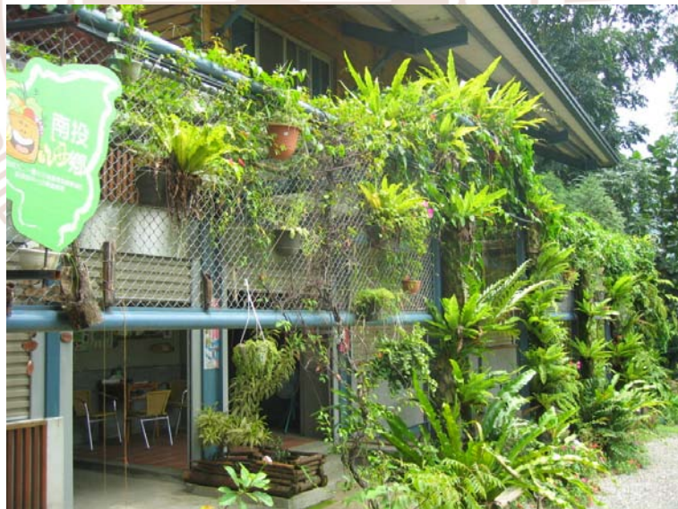
利用牆面外側設置攀爬架的方式來進行立面綠化，不僅可綠化量並塑造鄉村風貌(南投中寮)
