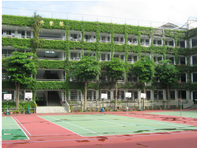
以蔓藤類植物直接攀附於建築牆面的方式(台中市仁愛國小)
