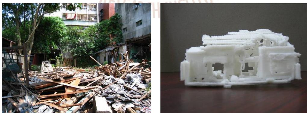
圖 5-36 日式宿舍倒塌後現況與逆向工程製做模型對照：齊東街 13 號現況(左) RP 模型(右)
