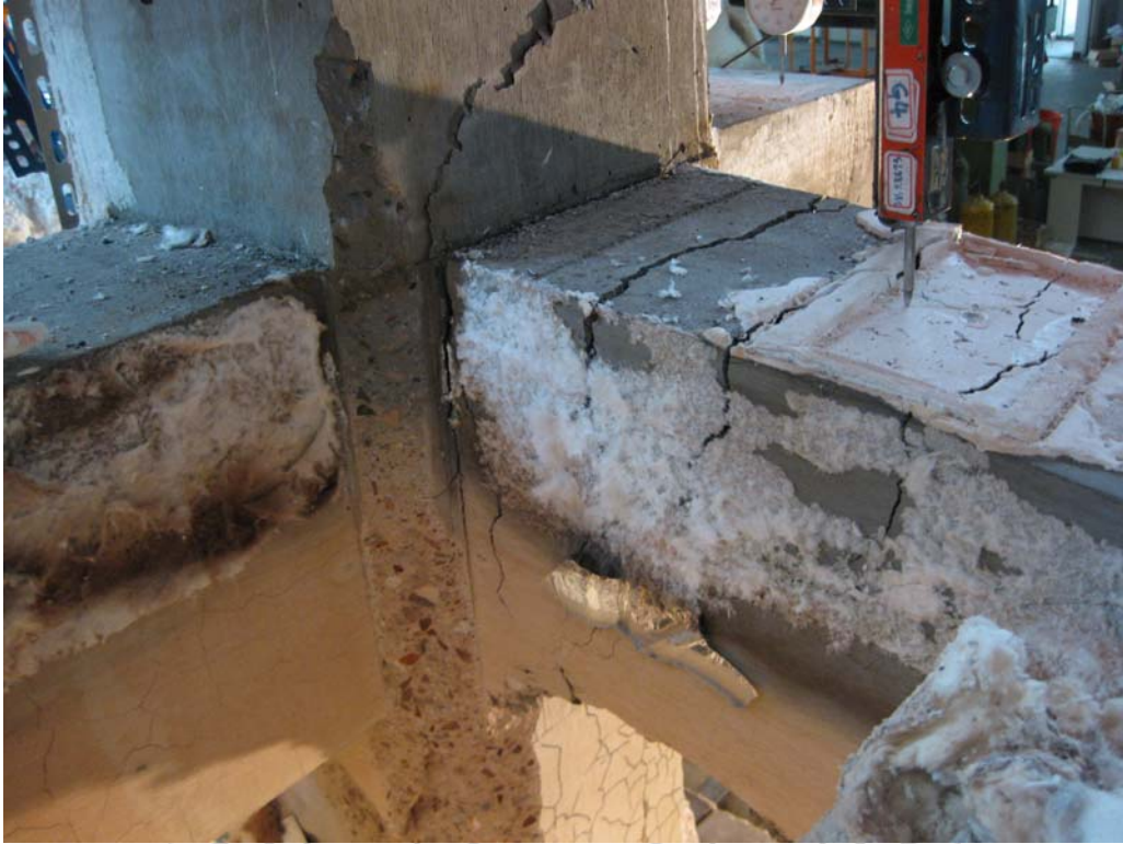
圖 4.53 (b) SCC3 殘餘極限承載試驗試體破壞照片 (2)
