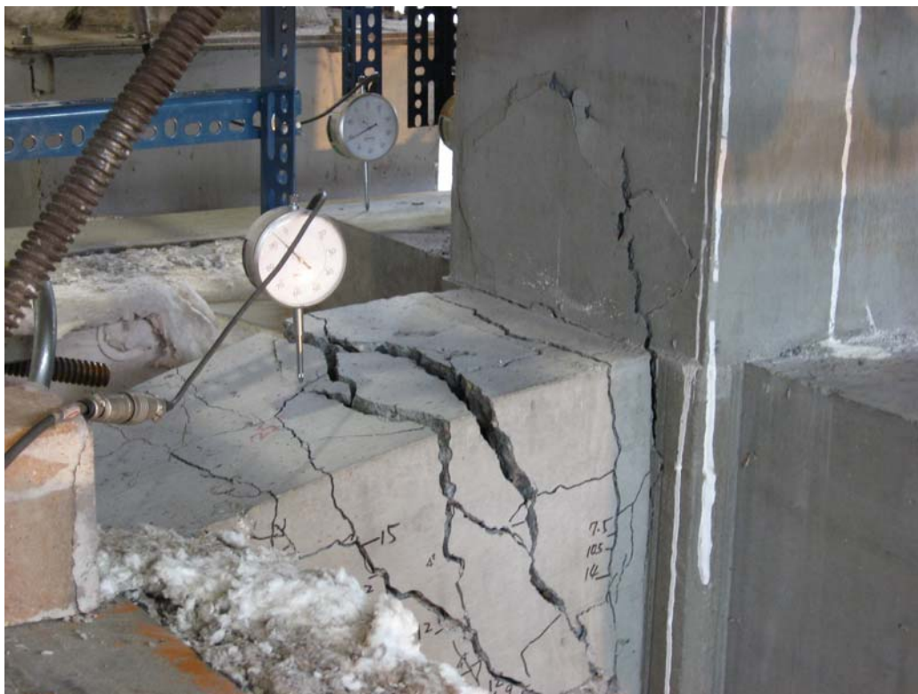
圖 4.39 (b) 常溫極限承載試驗試體破壞照片 (2)
