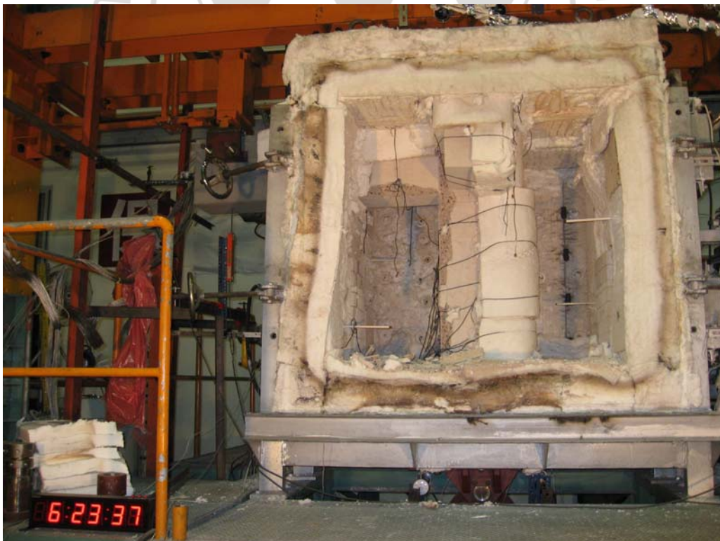
圖 4.33 SCC3 試體火害後照片
