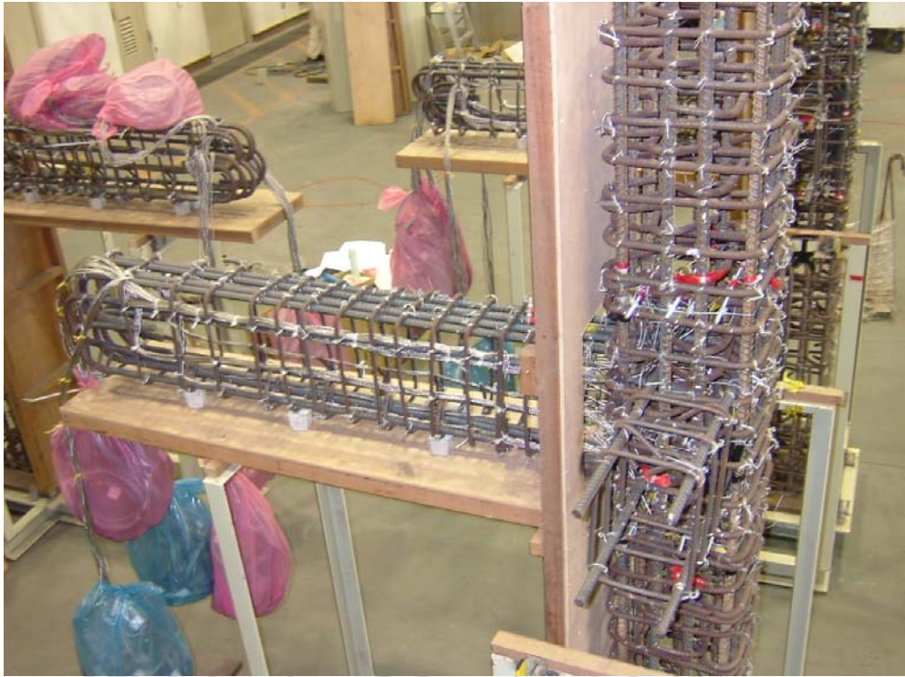
圖 3.21 梁柱鋼筋籠完成照片
