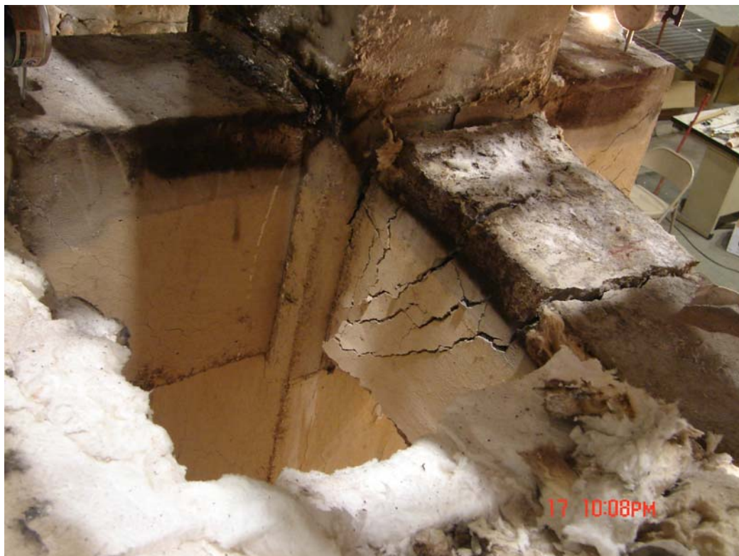
圖 4.49 (b) NC2 殘餘極限承載試驗試體破壞照片 (2)
