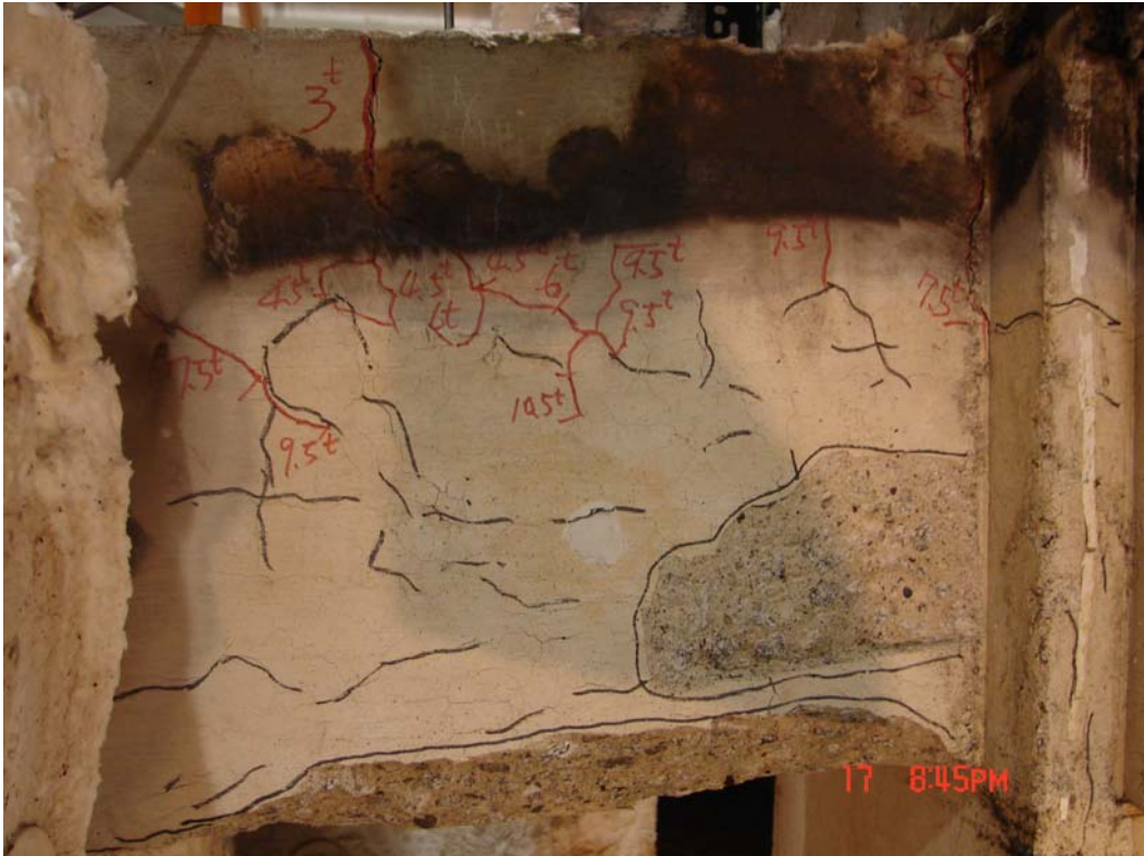
圖 4.48 NC2 殘餘極限承載試驗試體裂縫發展情形
