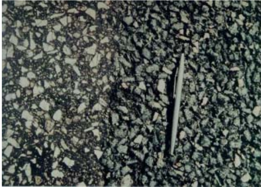
圖 2-2 排水性瀝青混凝土
