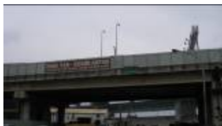
中山橋(第二省道洩洪橋)
