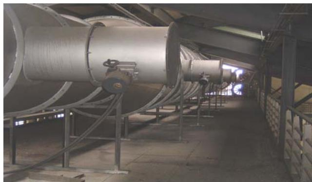
圖 6-27 實驗場地貓道上方之排煙系統實況圖
