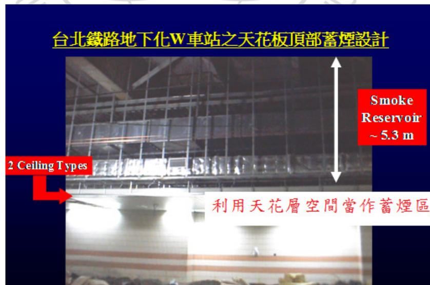
圖 5-11 某車站於流明天花內部設置機械排煙風管，並充分利用蓄煙區之良好設計
