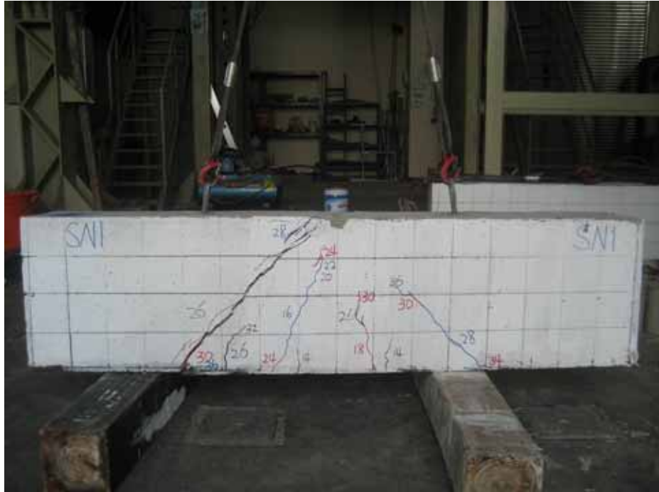
圖 4-7 梁之剪壓破壞
