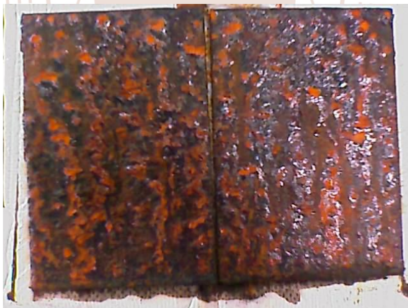
圖 6-2 鋼板基材無塗裝經鹽霧劣化 200 小時後情形 (本研究自行整理)
