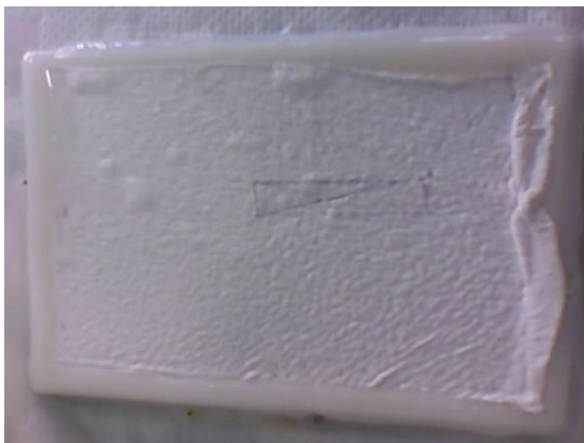
圖 6-1 鋼板基材塗裝防火漆經鹽霧劣化 200 小時後情形 (本研究自行整理)
