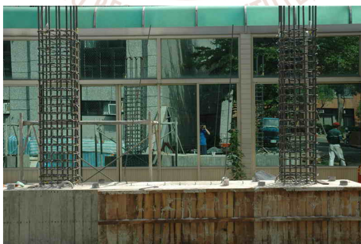
圖 3-22 柱筋綁紮 (資料來源：本研究拍攝)
