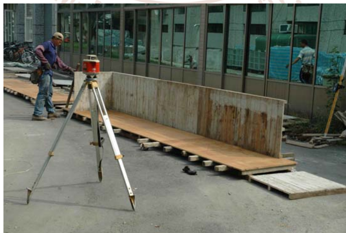
圖 3-19 基座模板整平
