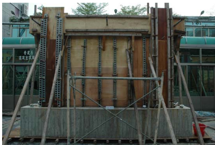
圖 3-23 預埋桿件及鋼管 (資料來源：本研究拍攝)
