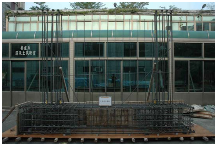
圖 3-20 柱筋、牆筋及 PVC 管安插 (資料來源：本研究拍攝)
