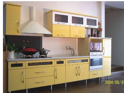
圖 3-36 人造石檯面+鋼烤面板(二)
