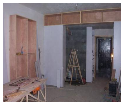
圖 3-42 櫥櫃製作圖(製作框架)
