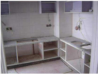
圖 3-49 廚具製作圖(釘製框架與隔板)
