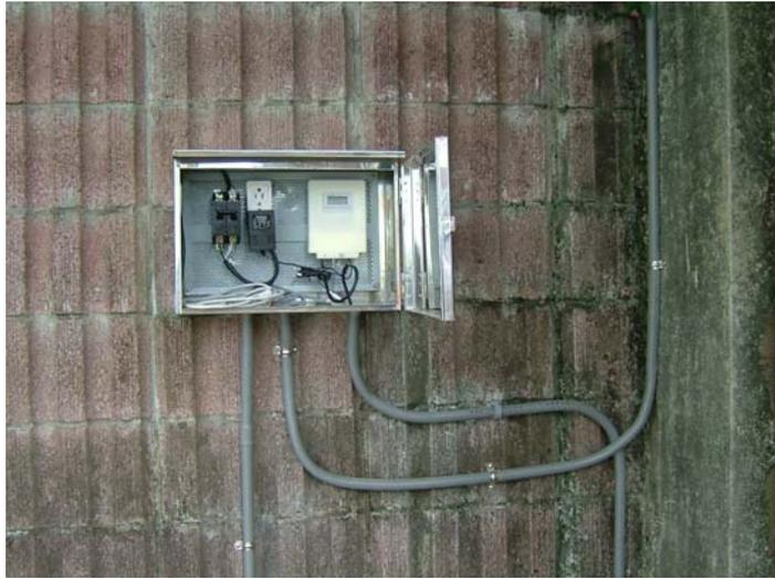
圖 5-10 水表介面管線建置 (2)
