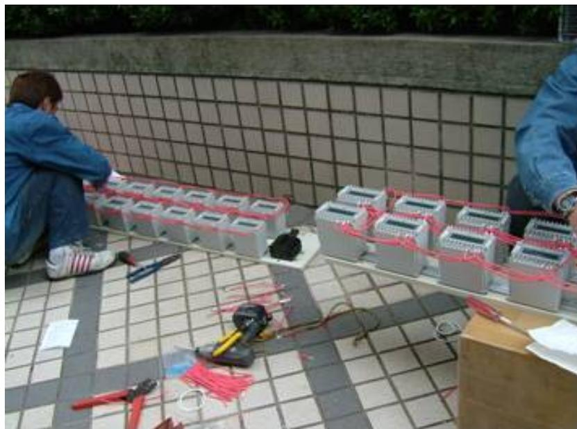
圖 5-19 數位電表表頭集中盤設備組裝
