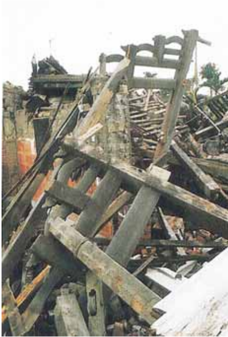
圖 3-8 石岡鄉民宅崩塌情形
