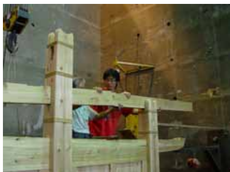
圖 2-49 在中柱外部組裝燕尾樑
