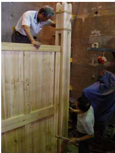
圖 2-43 堵板安裝完成
