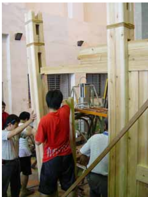
圖 2-45 立起前五架柱
