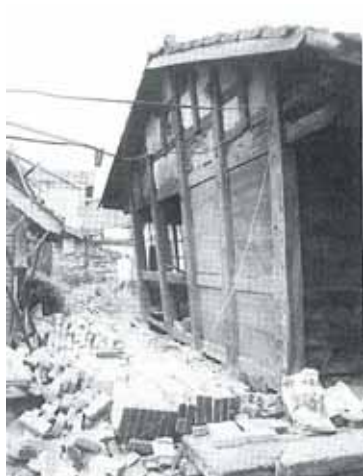
圖 3-10 穿鬥式木構架面外傾斜
