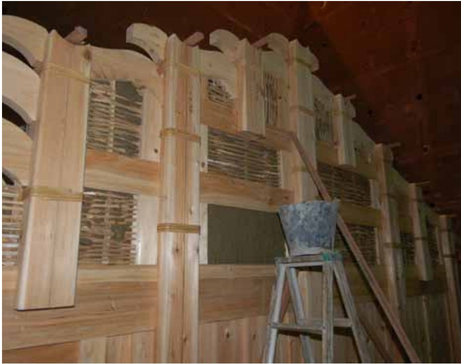
圖 2-54 在骨架外面塗抹米糠土
