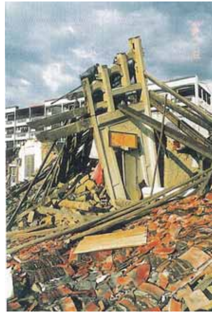
圖 3-9 東勢民宅崩塌情形
