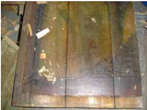
圖 2-16 平直型堵板
