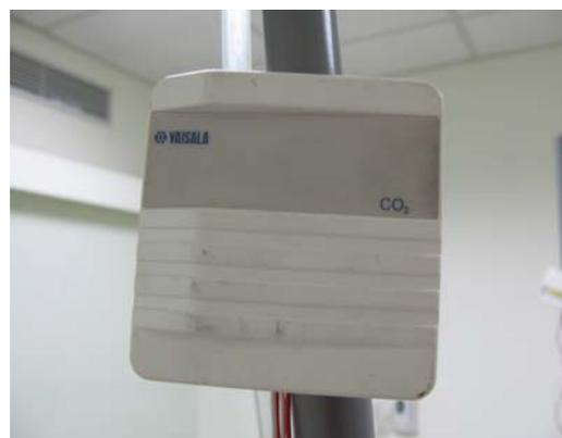
圖 4-9 GMW22 型 CO<sub>2</sub> 濃度感測器
