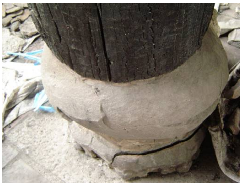
照片 3-7 柱珠石材假固定前照片
