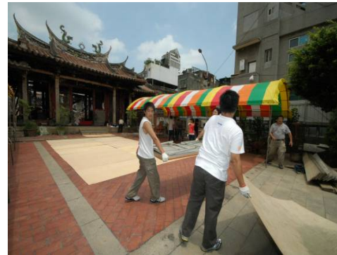
照片 3-4 地坪鋪夾板保護照片
