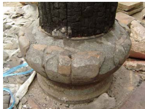
照片 3-8 柱珠石材假固定後照片
