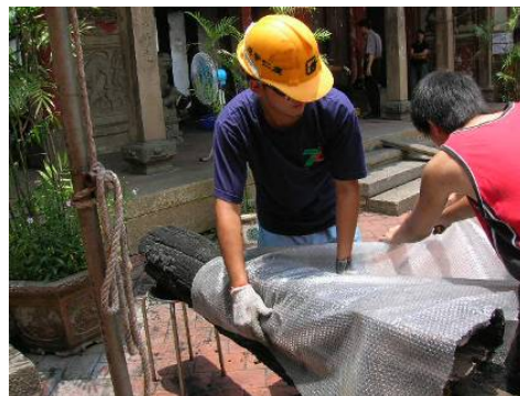
照片 3-14 包覆構件紀錄照片
