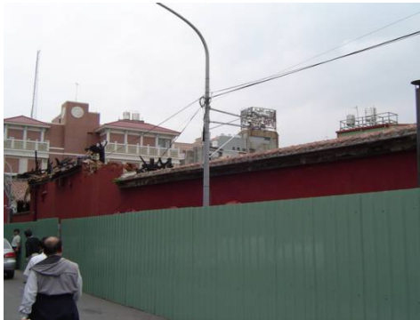
照片 3-1 右後側甲種圍籬照片
