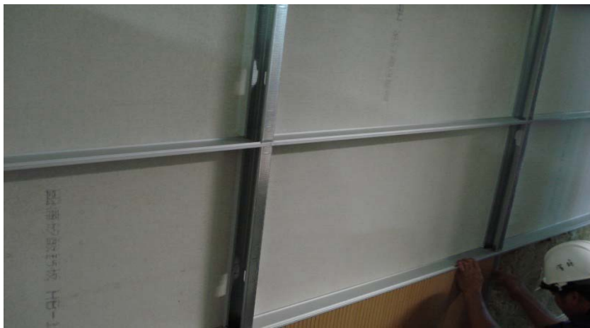
圖 2-7 室內牆面裝修輕鋼架圖
