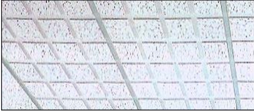
圖 2-3 半明架天花板完成圖
