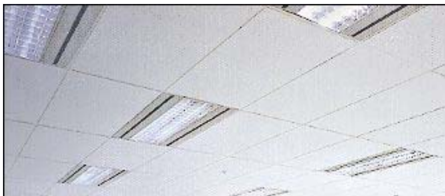
圖 2-5 明暗架天花板完成圖
