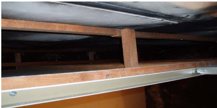
圖 2-4 木角材暗架天花板施工圖
