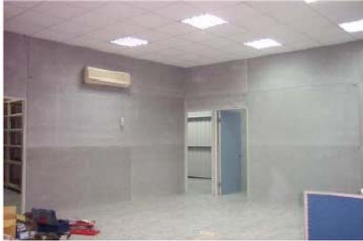
圖 2-3 水泥纖維板應用於室內的隔間施工[9]
