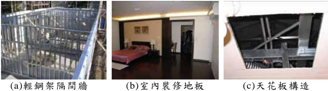
圖 4-14 國內「版片式」住宅系統之室內裝修構造
