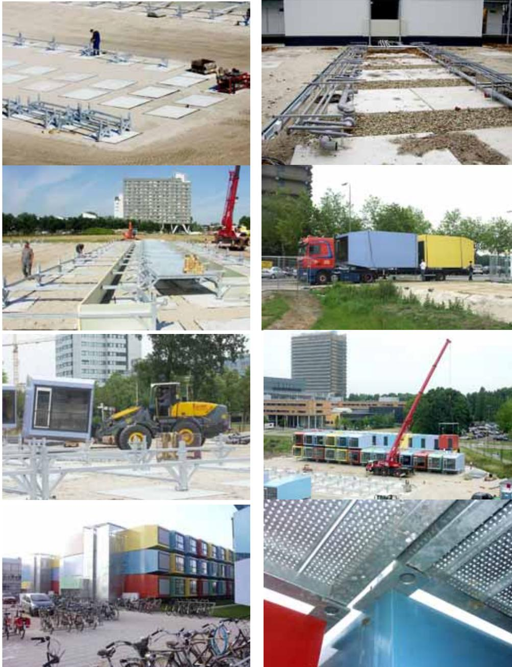
圖 5-23 Space Box 施工程序
