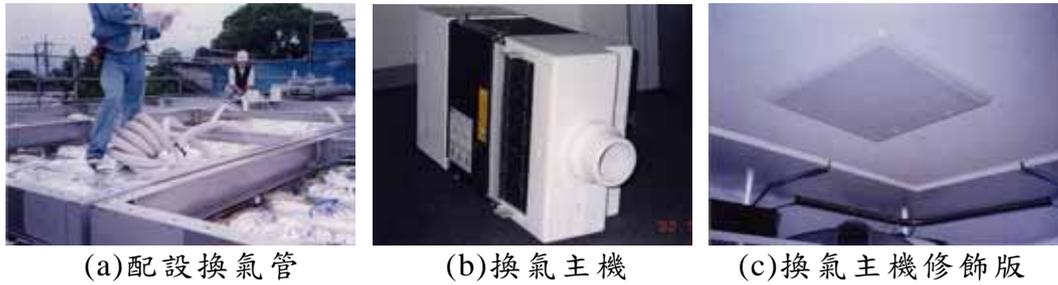
圖 4-23 國內「箱體式」住宅系統之室內空氣換氣系統
