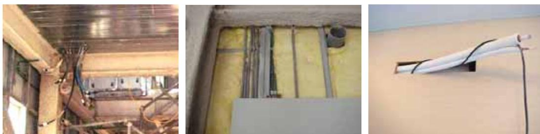
(a)水電管線系統 (b)衛浴系統、濕式施工 (c)空調系統與管線
