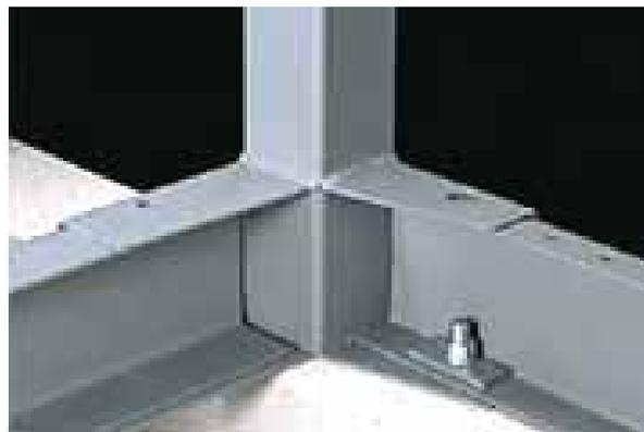
圖 5-41 RC 基礎與箱體型鋼骨架的接合方式
