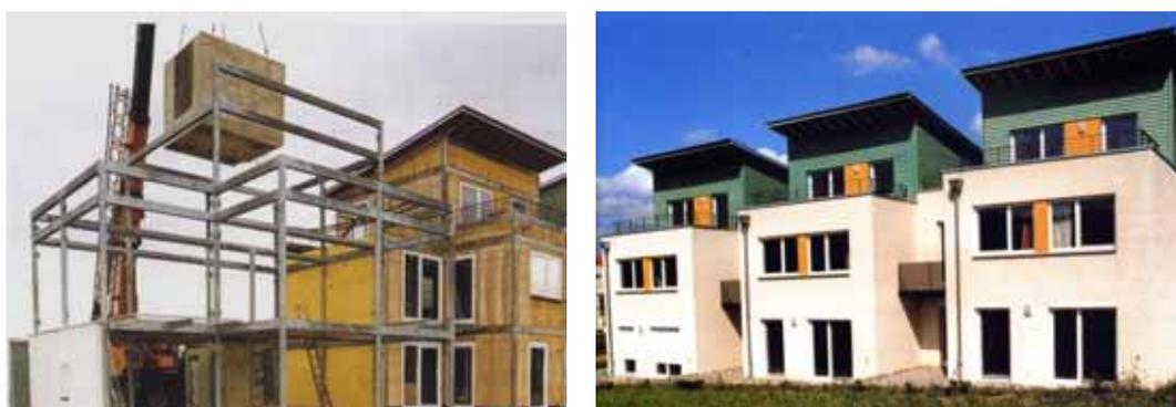
圖 5-5 Dywidag System 之框架系統與箱式整體衛浴之吊裝(左)。「Hessental」之原型屋外觀(右)
