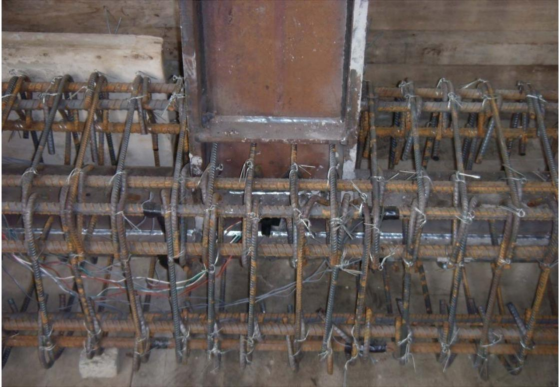
照片 3.1 鋼骨與鋼筋之組合
