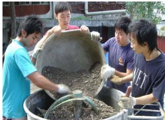
圖 3.23 混凝土拌合
