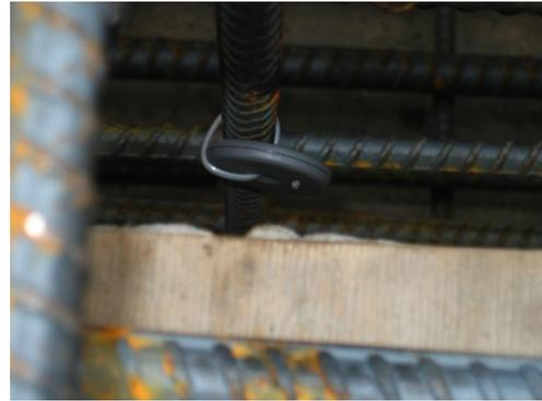
圖 4.57 高頻防磁標籤綁紮於版上鋼筋
