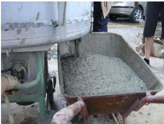
圖 3.24 混凝土卸料
