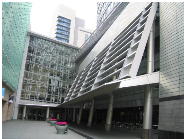
日本—東京「森」大樓(陳文樹拍攝提供) 說明：帷幕牆造型，具有水平及垂直遮陽的效果。
