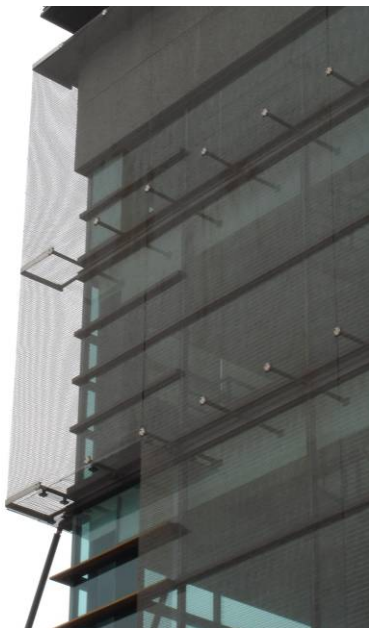
台灣—新竹大樓 (陳文樹拍攝提供) 說明：舊大樓改善隔熱採用 LOW-E 玻璃當遮陽。
