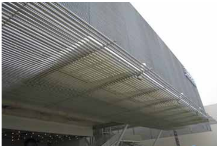
圖 3-9 日本—2005 年愛知博覽會某展覽館 說明：採用水平遮陽(鋁管)，水平遮陽外伸尺寸約 1.8M 具有遮陽及造型功能。 (陳文樹拍攝提供)
