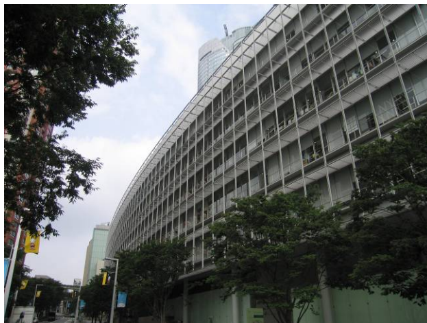
日本—東京「森」大樓(陳文樹拍攝提供) 說明：玻璃帷幕牆採用水平遮陽架及垂直飾條。
