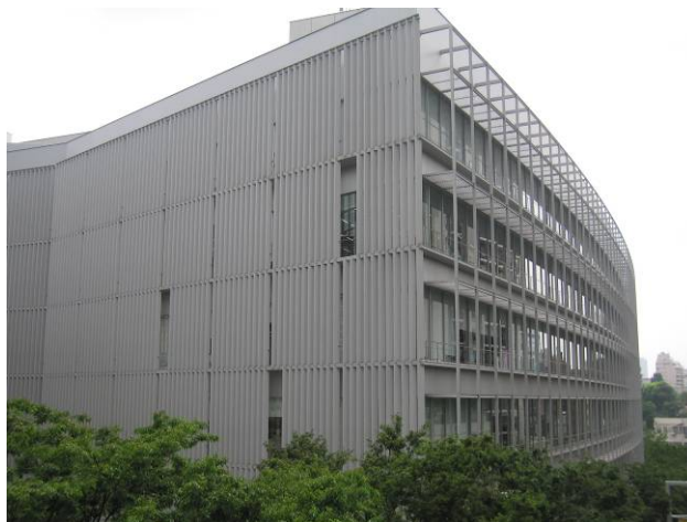
日本—東京「森」大樓(陳文樹拍攝提供) 說明：玻璃帷幕牆採用水平遮陽架，西向採用垂直遮陽架。
