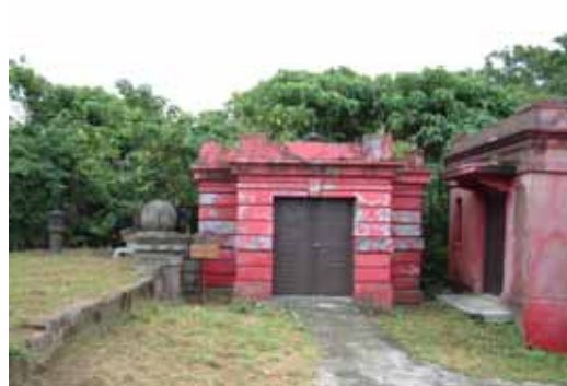
台北水道水源地石砌外牆
