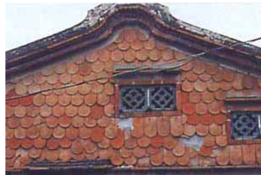
*2 霧峰某宅外牆面加貼面磚(穿瓦衫)
