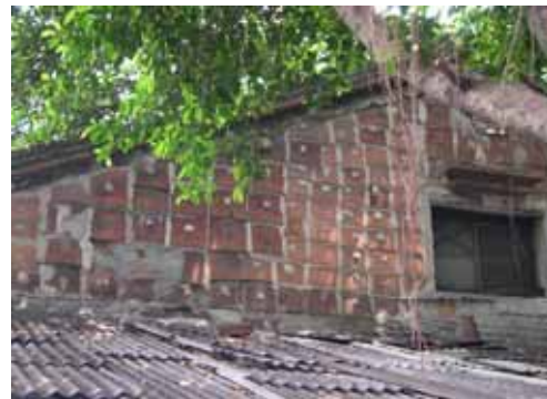
照片3 台北某宅外牆面加貼面磚(穿瓦衫)
