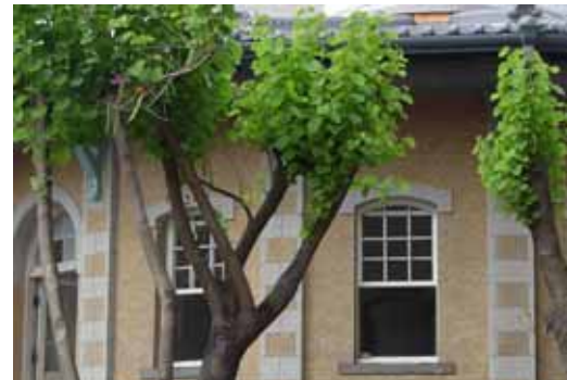
*1 原台南測候所磚砌牆體外貼十三溝面磚
