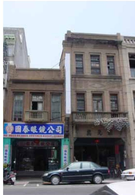
彰化鹿港十宜樓外牆飾洗石子
