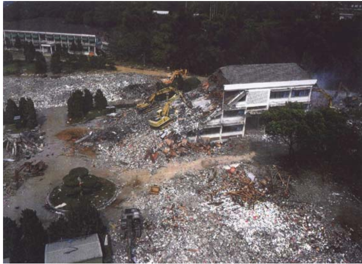
圖 3- 2 省政府辦公大樓外面進行拆除的方法
