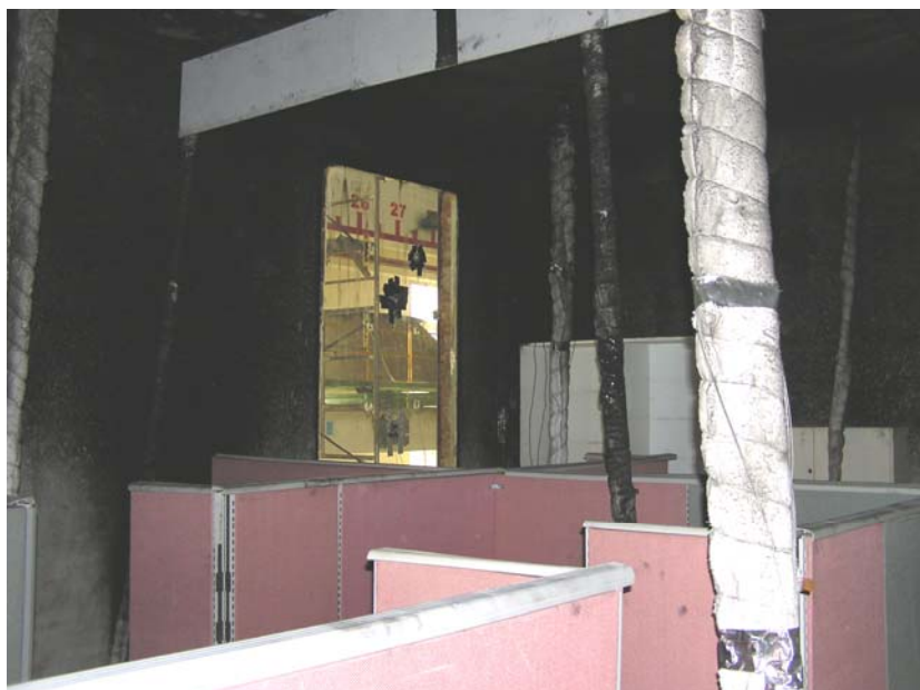
圖 5-1(b) 由東南開口觀察辦公室內部點火前的狀況(中間為西牆防火窗)
