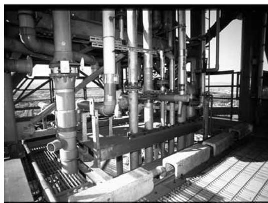
圖 3.27 日本東京八王子都市基盤整備公團 108m 排水實驗塔中間層配管
