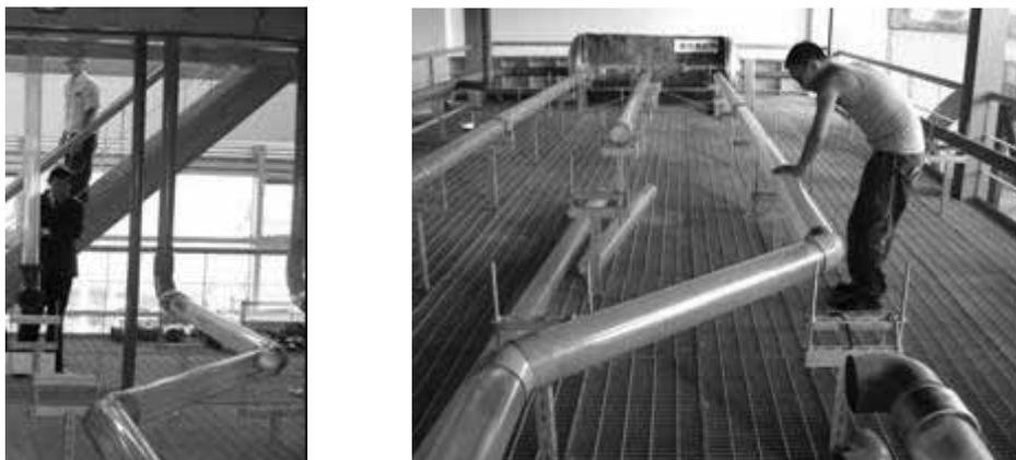
圖 3.8 排水橫管 45 度轉折修改狀況<sup>[12]</sup>
