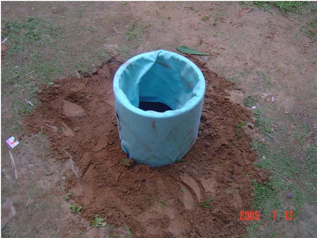
圖 5-19 試驗滲透陰井鋪設完成圖
