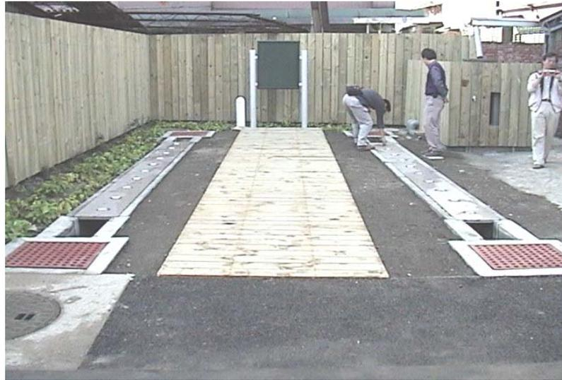
圖 3-10 具實驗與示範性質的滲透側溝
