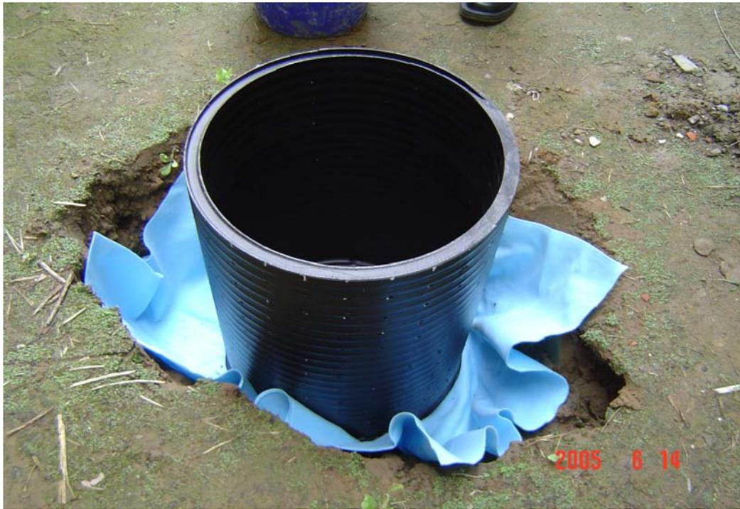
圖 5-17 試驗滲透陰井鋪設概況 (3)
