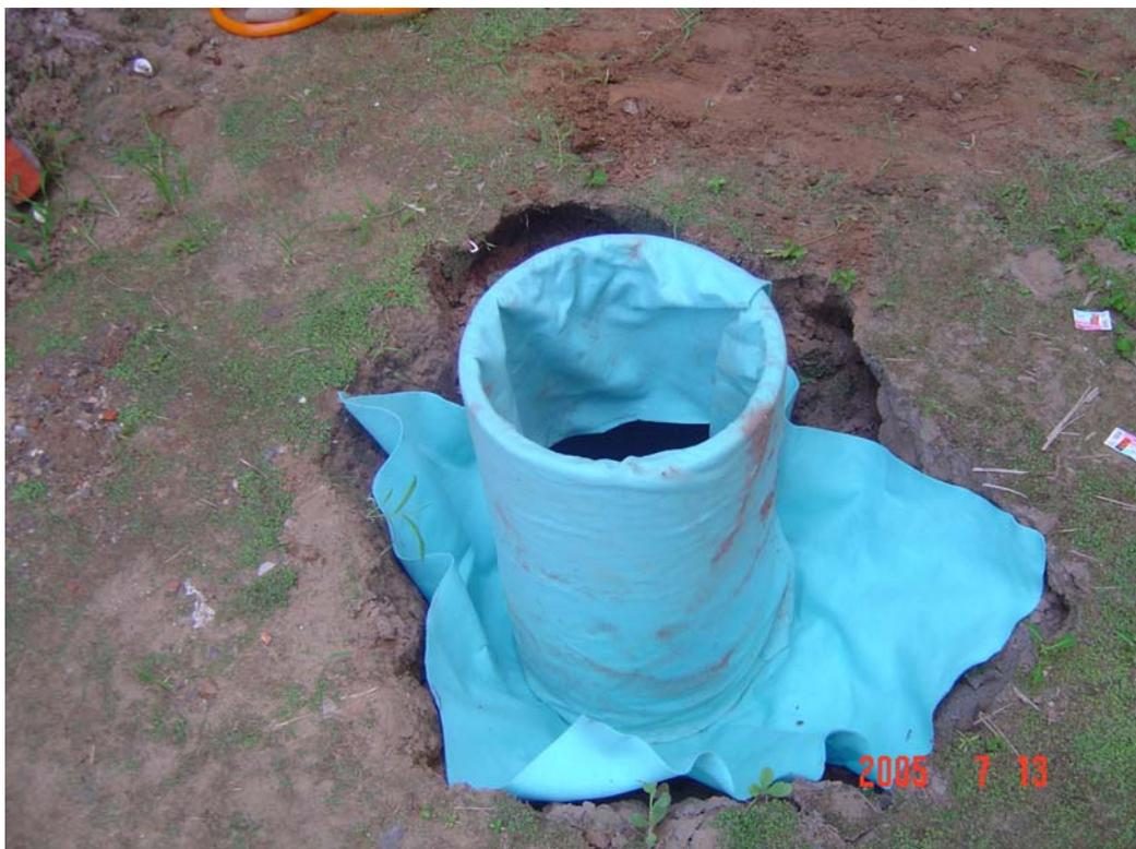
圖 5-18 試驗滲透陰井鋪設概況 (4)
