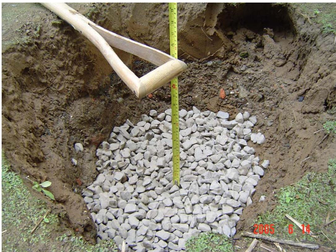
圖 5-15 試驗滲透陰井鋪設概況 (1)
