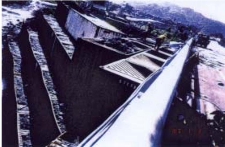
圖 3-8 挖土機將土由上部挖除的開口填入的情形
