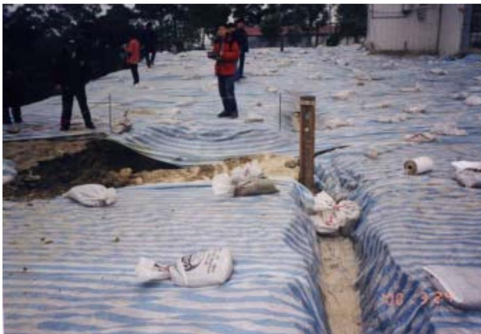
圖 3-13 打設鋼軌，覆蓋帆布並以砂袋固定
