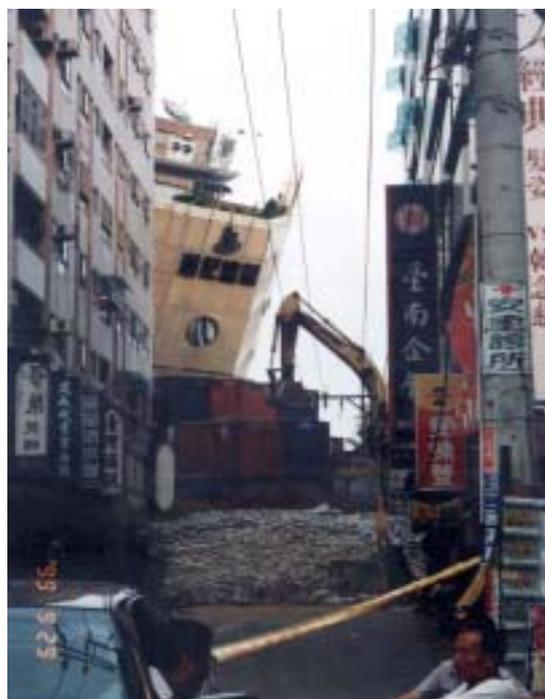
圖 3-10 漢記大樓拆除前，以貨櫃堆疊及以挖土機填入土石的方式防止建物持續傾斜
