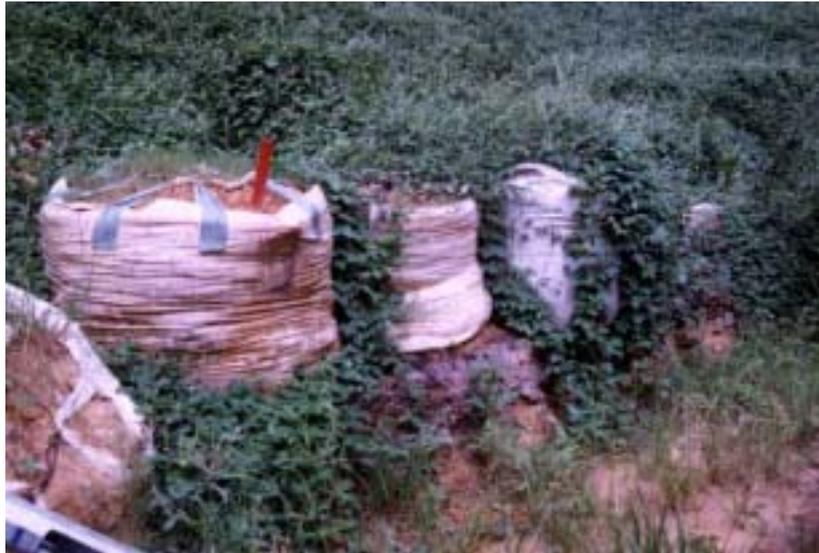
圖 3-21 於邊坡下方以太空包增加坡趾壓力防止再次滑動
