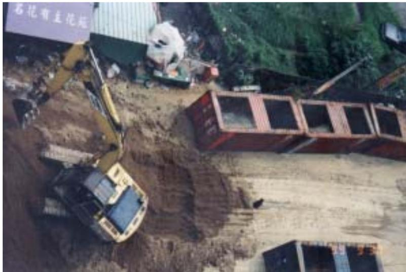
圖 3-11 挖土機將土石填入貨櫃的情形
