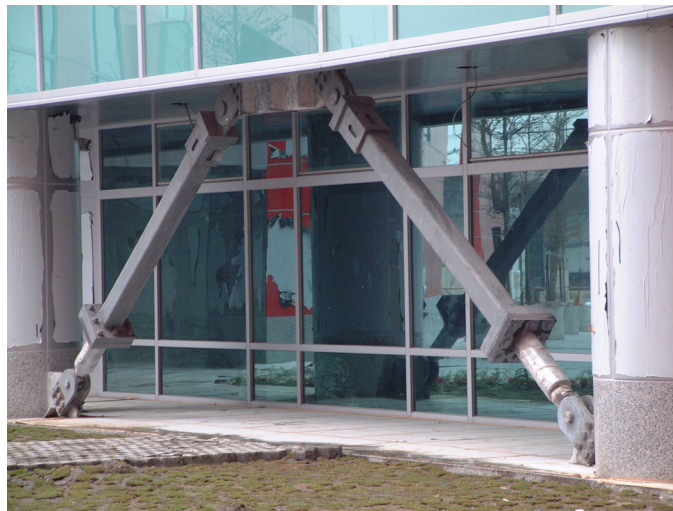
圖 2.12 含流體黏滯阻尼器之倒 V 字型斜撐
