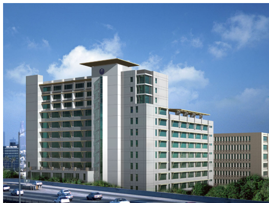
圖 2.8 台灣科技大學第五綜合大樓新 建工程
