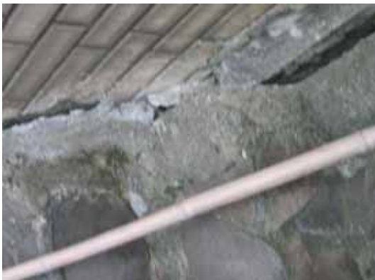
照片 5-9 填方區住宅地坪沉陷分離現況 (照片來源：本研究攝製)
