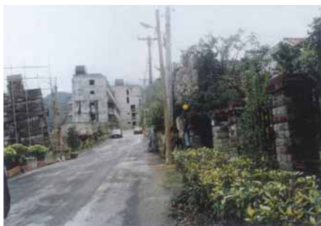
照片 2-3 主崩崖頂附近道路復原 (照片來源：台灣省大地技師公會提供)
