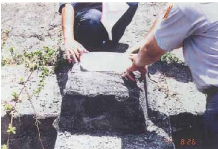
照片 2-23 坍塌區中 A 區之地錨保護座外觀無顯著之破壞 (照片來源：台灣省大地技師公會提供)
