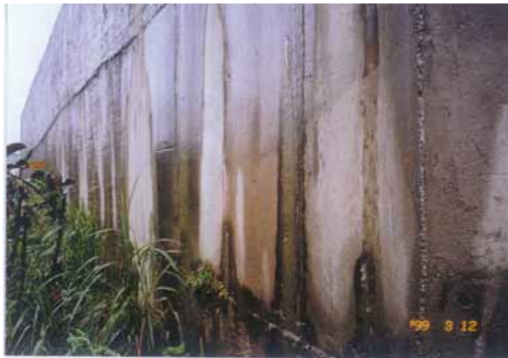
照片 2-11 擋土牆有明顯噴水及滲水現象 (照片來源：台灣省大地技師公會提供)
