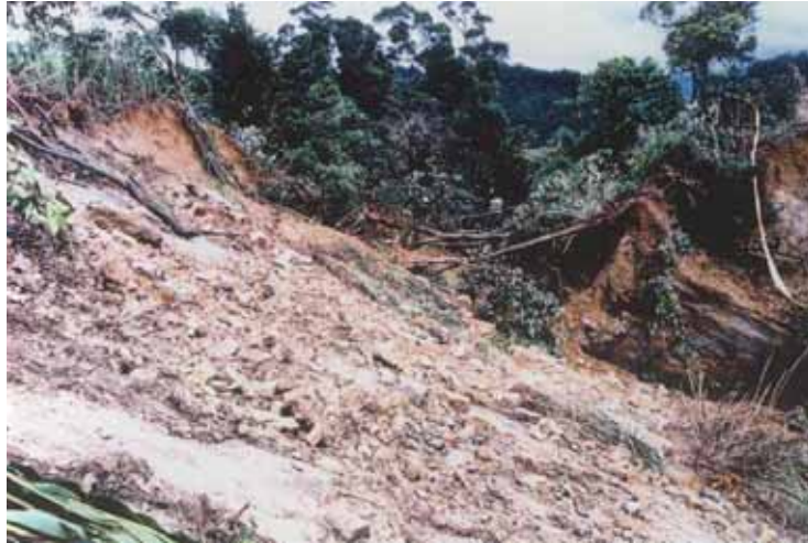
照片 2-29 滑動面最上端之橫向張力裂縫 (照片來源：台灣省大地技師公會提供)
