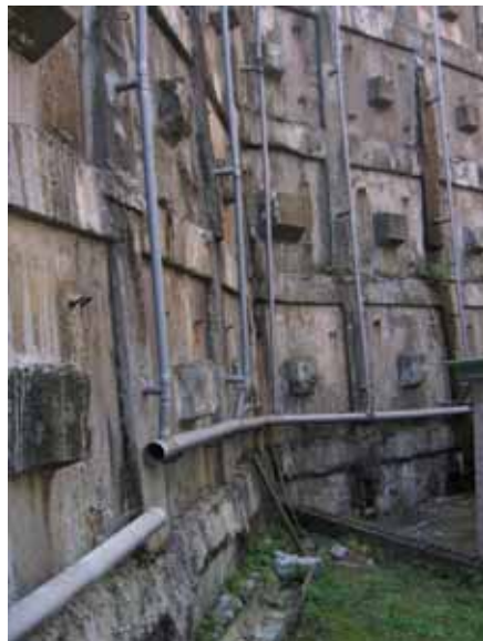
照片 5-4 上邊坡擋土牆現況 (照片來源：本研究攝製)
