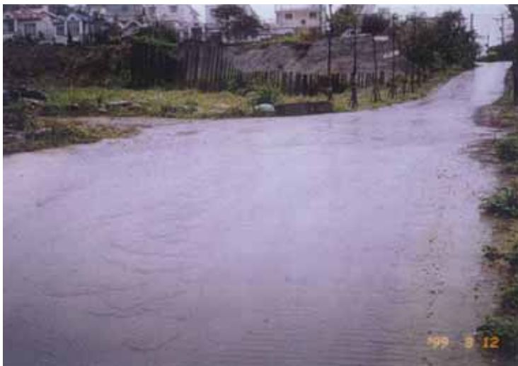
照片 2-9 道路缺乏橫向截流溝，地表水四處漫流 (照片來源：台灣省大地技師公會提供)
