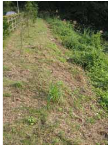
照片 5-12 崩塌地坡面現況
