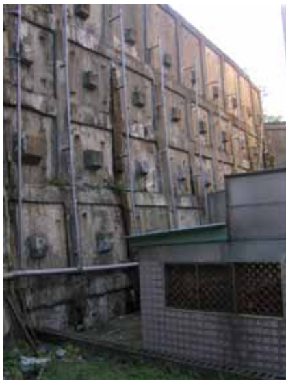
照片 5-3 上邊坡擋土牆現況 (照片來源：本研究攝製)
