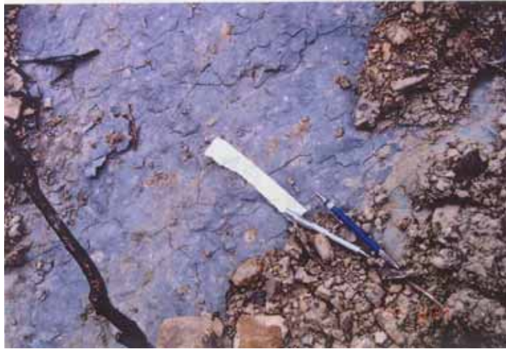
照片 2-31 台電高壓電塔下方露出之最下層滑動面情形(近景)
