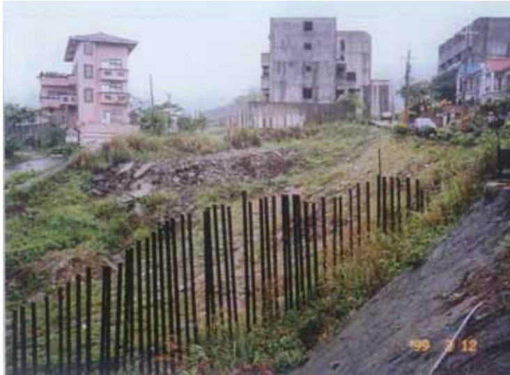
照片 2-10 採噴漿護坡及鋼軌樁加以擋土原有破壞之建築已拆除 (照片來源：台灣省大地技師公會提供)
