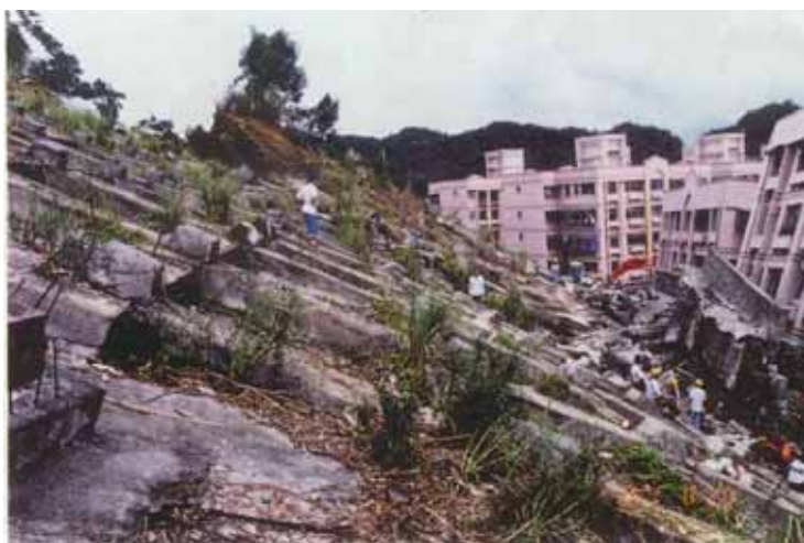
照片 2-20 坍塌屈西側邊坡滑動後， 部分格梁尚維持完整之情形 (照片來源：李景亮技師提供)
