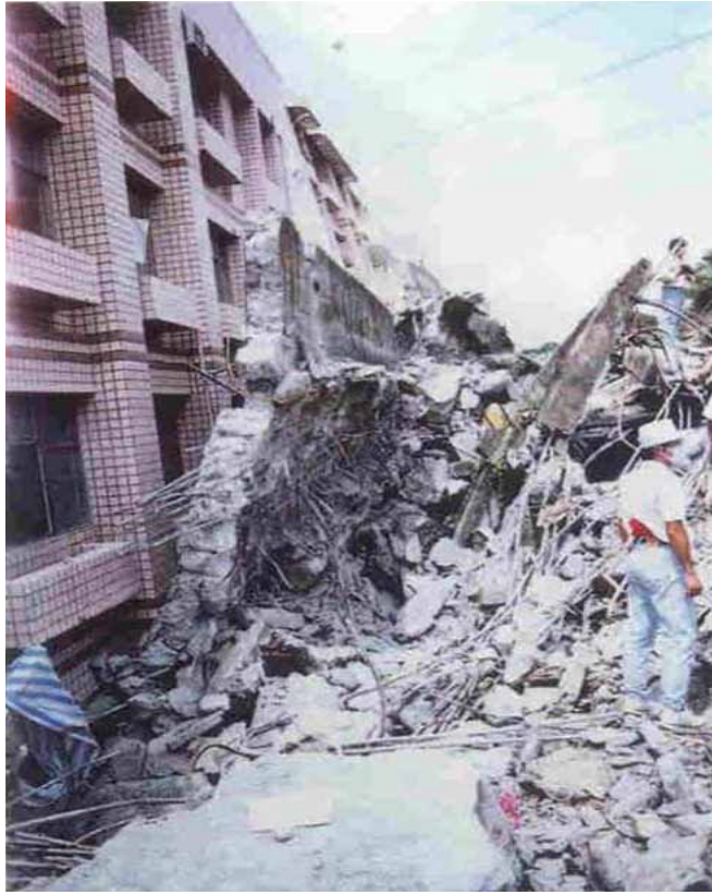
照片 2-18 第三區北側擋土牆傾倒情形 (照片來源：李景亮技師提供)
