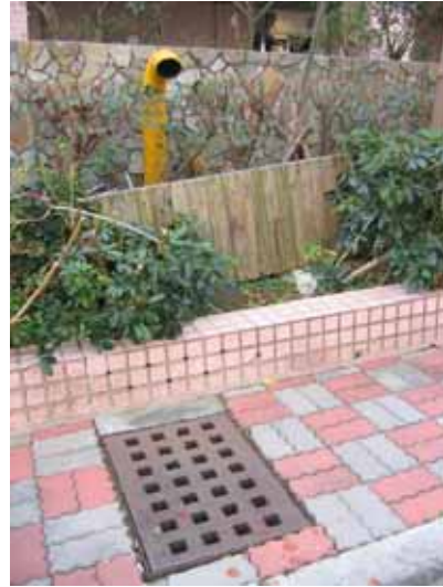
照片 5-2 人行步道排水孔現況 (照片來源：本研究攝製)
