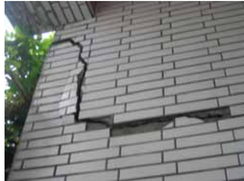
照片 5-8 填方區住宅牆面裂縫現況 (照片來源：本研究攝製)
