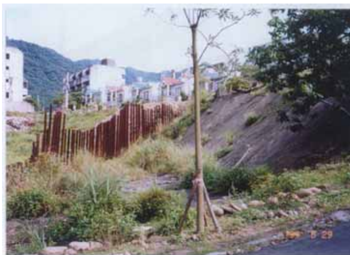
照片 2-2 崩坍區四周之兩層樓別墅及四樓公寓 (照片來源：台灣省大地技師公會提供)
